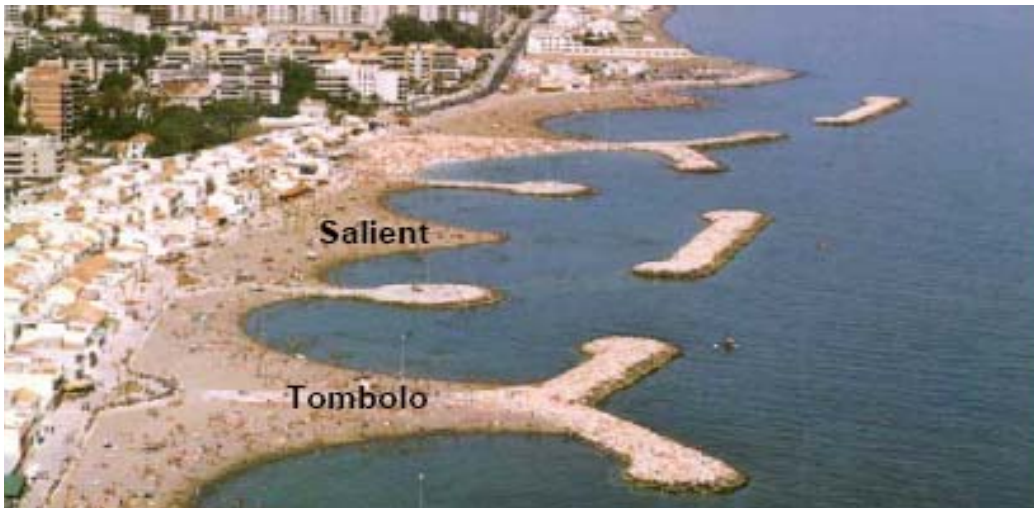
Σχήμα 1.4: Σχηματισμοί Tombolo και Salient που εμφανίστηκαν στην τεχνητή παραλία του Pedregalejo στη Μάλαγα της Ισπανίας (DELOS, 2004). Σημειώνεται ότι η στέψη των κυματοθραυστών που απεικονίζονται στη φωτογραφία βρίσκεται πάνω από της στάθμη της θάλασσας
