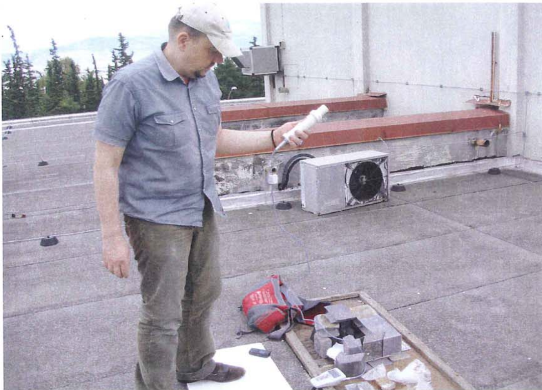
Εικ 7.83: Κατά την διενέργεια των μετρήσεων, η λήψη των τιμών περιβάλλοντος σε απόσταση 150cm από τον μολύβδινο κλωβό.
