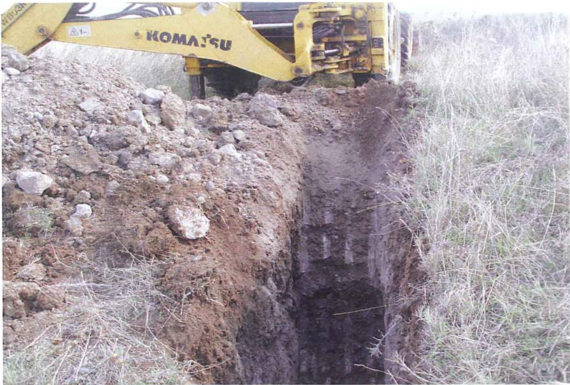
Εικ.3.59: Η τομή Γ3 στην κορυφή του υψώματος σε θέση που μας υπέδειξε ο Χρ. Κακαρνιάς. (φωτ. Θ. Κατσαρός).
