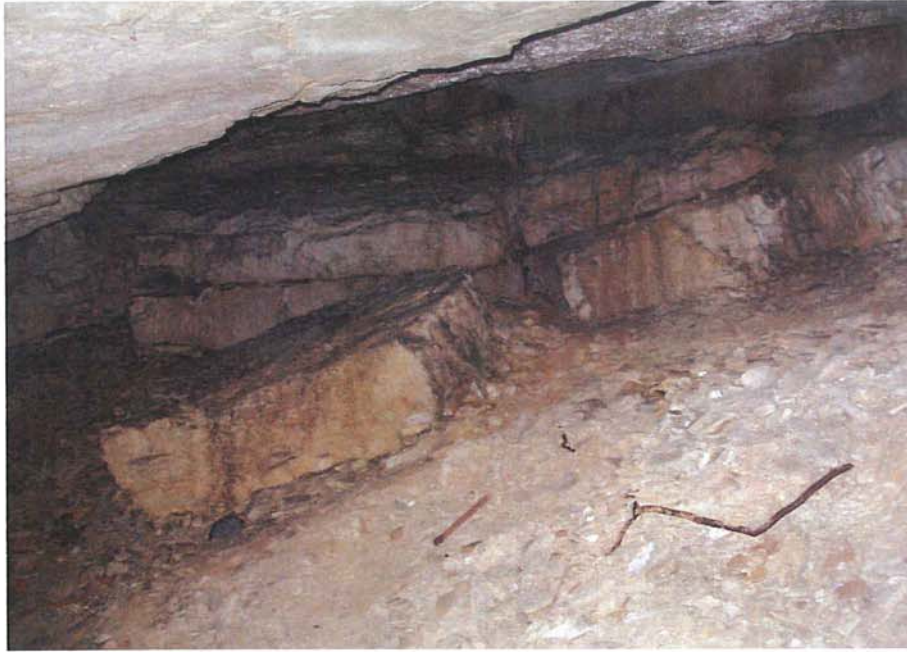
Εικ.3.33: Εσωτερικό της στοάς της Παναγίας της Σπηλιανής όπου διακρίνεται η πτώση της οροφής του αρχικού ορύγματος. (φωτ. Θ. Κατσαρός).
