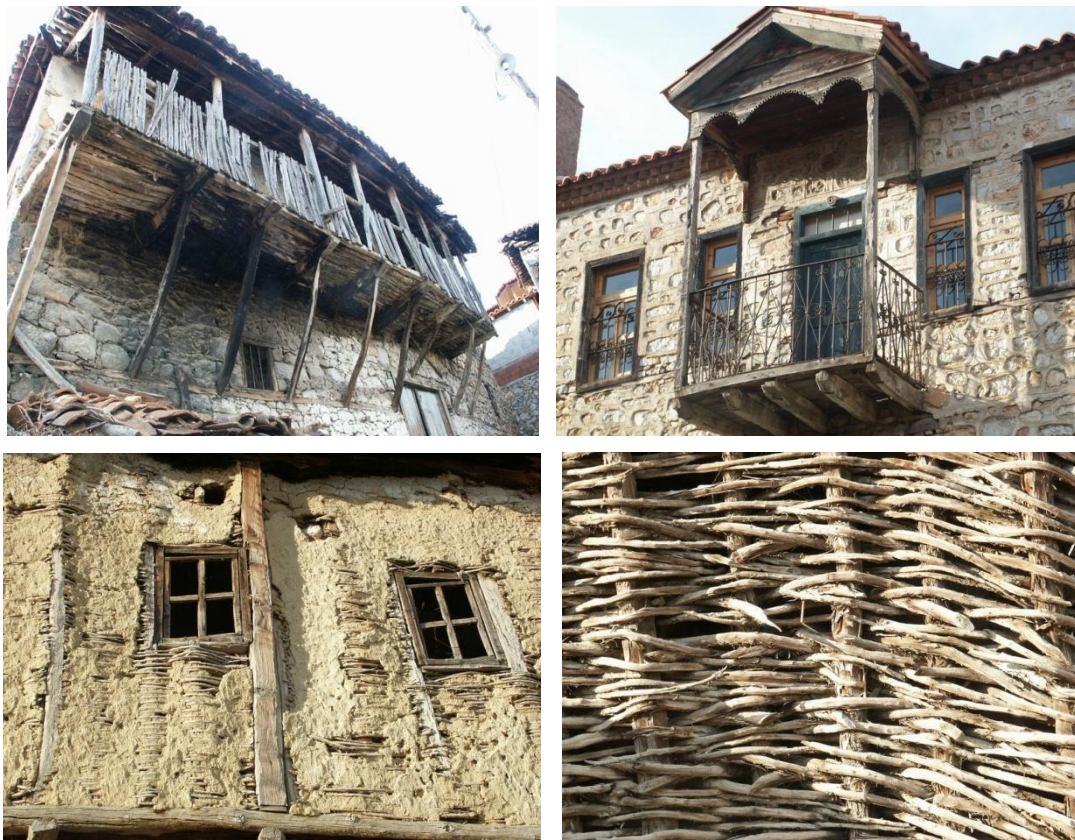
Εικόνες 3.7-3.10. Απόψεις και λεπτομέρειες από παραδοσιακά σπίτια στον οικισμό των Ψαράδων.
