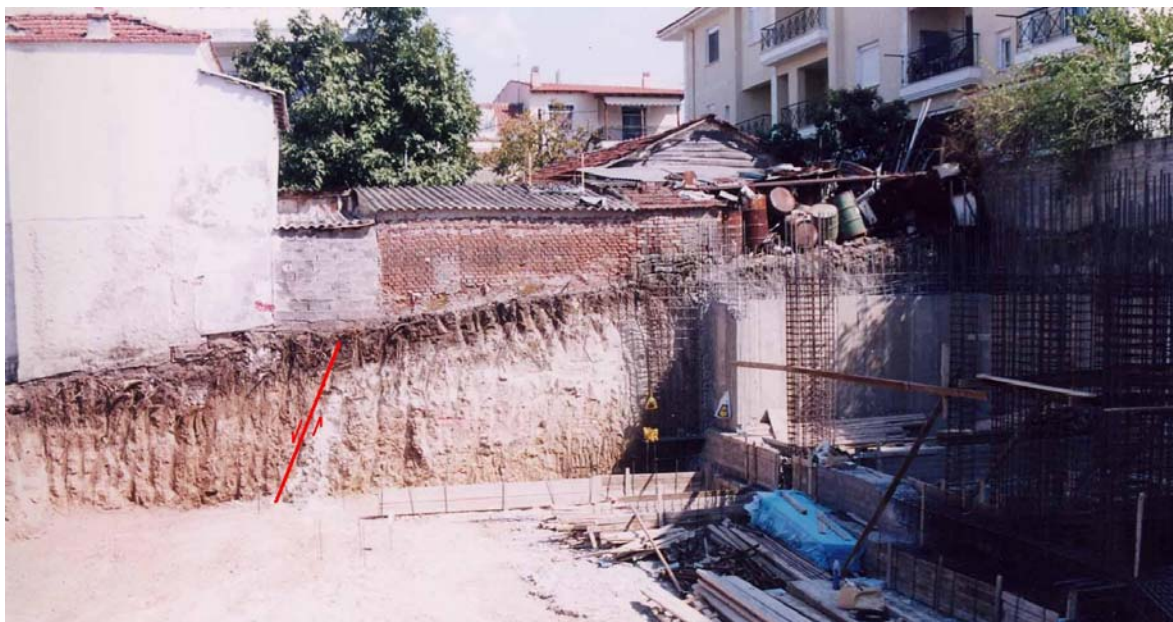
Φωτογραφία 6.7 . Το ρήγμα όπως εμφανίζεται (κόκκινη γραμμή) στην ανατολική πλευρά του οικοπέδου.
