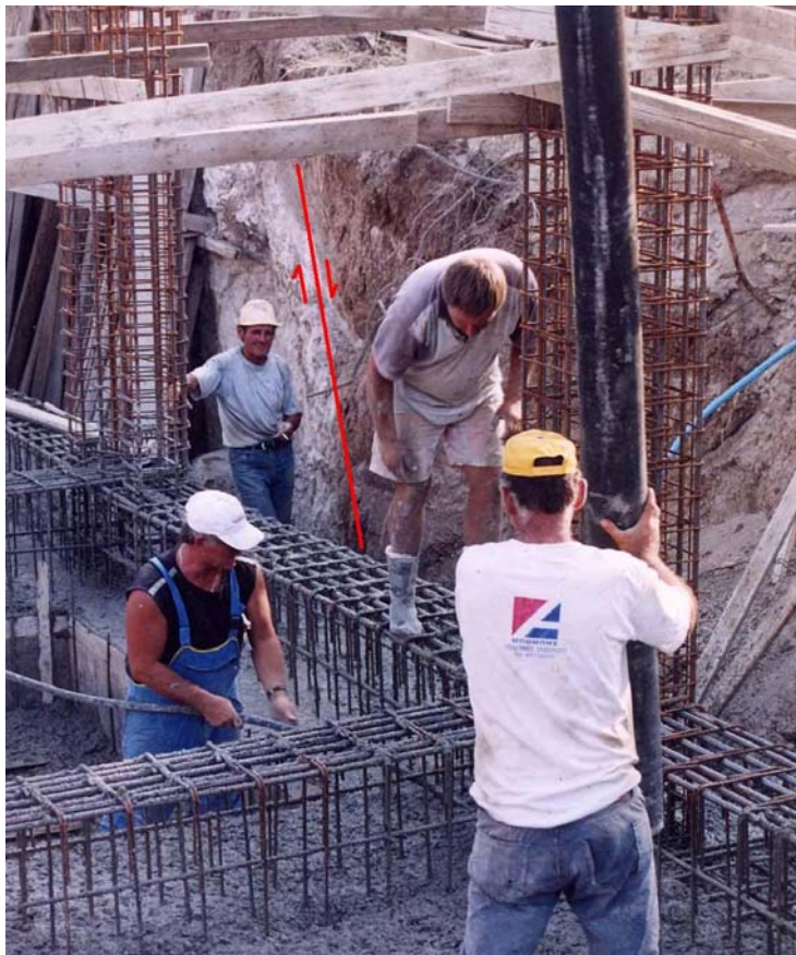
Φωτογραφία 6.6. Έργα θεμελίωσης της οικοδομής στην Μ.Αλεξάνδρου και χαρακτηριστική εμφάνιση του ρήγματος (κόκκινη γραμμή).
