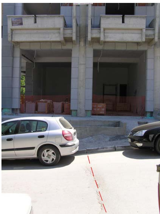
Φωτογραφία 6.8. Η ανέγερση τελικά της οικοδομής όπως φαίνεται από την οδό Μ. Αλεξάνδρου και τα ίχνη των διαρρήξεων (κόκκινη διακεκομμένη γραμμή), που εμφανίζονται κατά μήκος του ρήγματος που φαίνεται στις παραπάνω φωτογραφίες. (Φώτο: Λεωνίδας Τσιώκος).
