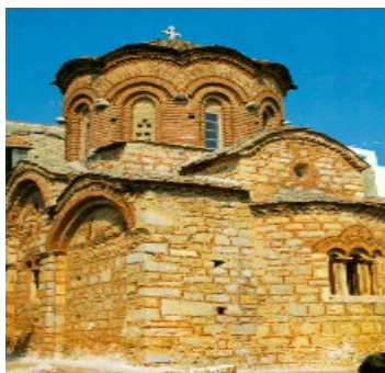
Εικόνα 24: Η εκκλησία των Αγ. Αποστόλων (Πηγή:
