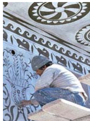
Εικόνα 23: Τεχνίτης εν ώρα κατασκευής ξυστού (Πηγή: http://www.in.gr/agro/chios/nomos16.htm )
