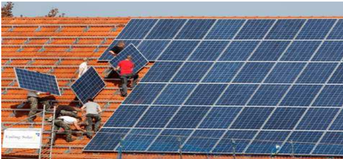
Εικόνα 12 Οικιακό φωτοβολταϊκό Σύστημα ( ΠΗΓΗ: http://content-mcdn.ethnos.gr/filesystem/images/20120729/engine/assets_LARGE_t_420_54092716_type12128.jpg )
