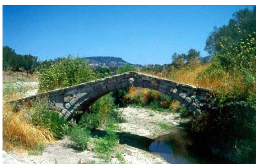
Εικόνα 3. Γέφυρα Αγ. Παρασκευής
