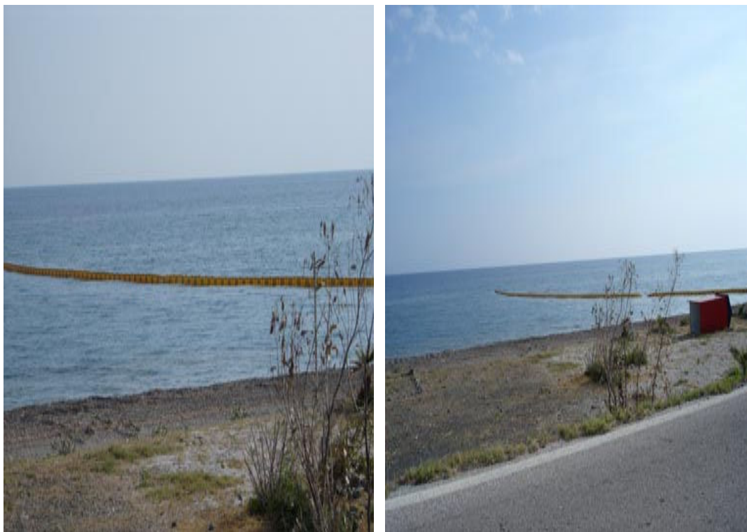
Εικόνα 4 & 5: Τοποθέτηση πλωτού φράγματος στην παραλία των Βατερών
