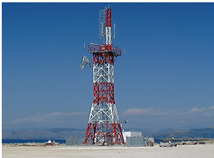
Εικόνα 2: Τυπικός σταθμός αισθητήρων. Πηγή: YEN
