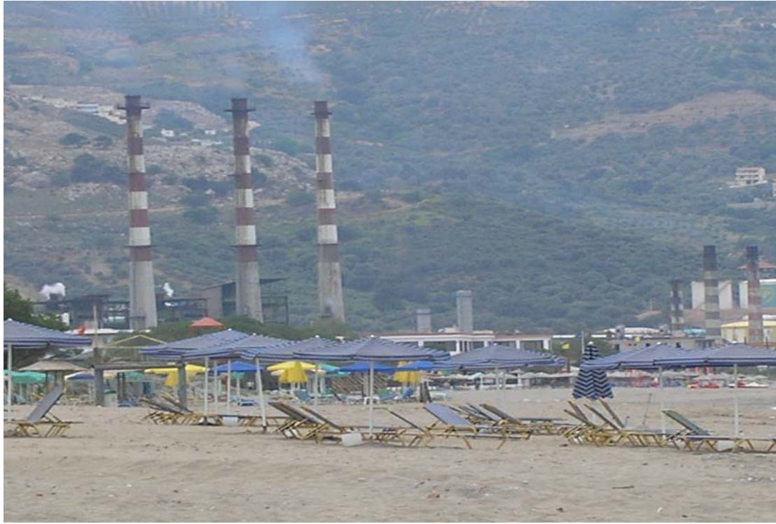
Εικόνα 5. Ακτή Αμουδάρας – Σταθμός ΔΕΗ. Σε αναμονή παραθεριστών (Μάιος 2006)
