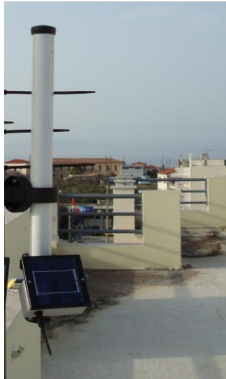
Εικόνα 17: Η τελική όψη του σταθμού στο Καρλόβασι Σάμου (Narda AMB 8057)
