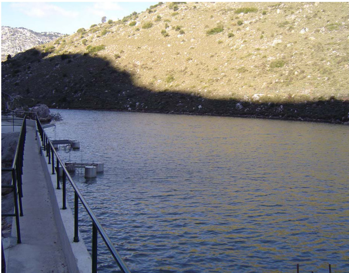
Σχήμα Γ-14 – Φράγμα Ψαρόπετρας
