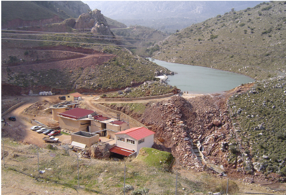
Σχήμα Γ-11 Φράγμα Ψαρόπετρας
