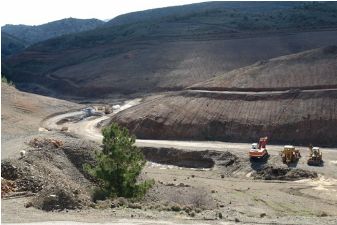
Σχήμα Γ-7 - Φράγμα Σαραπιού
