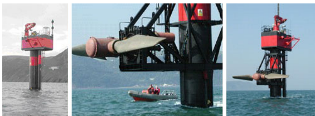
Σχήμα 3.14: Εικόνα της συσκευής της MCT όπως φαίνεται στη θάλασσα. Η πτερωτή βρίσκεται μέσα στη θάλασσα (α), ενώ βγαίνει στην επιφάνεια για να συντηρηθεί (β), (γ). (Πηγή: www.marineturbines.com )
