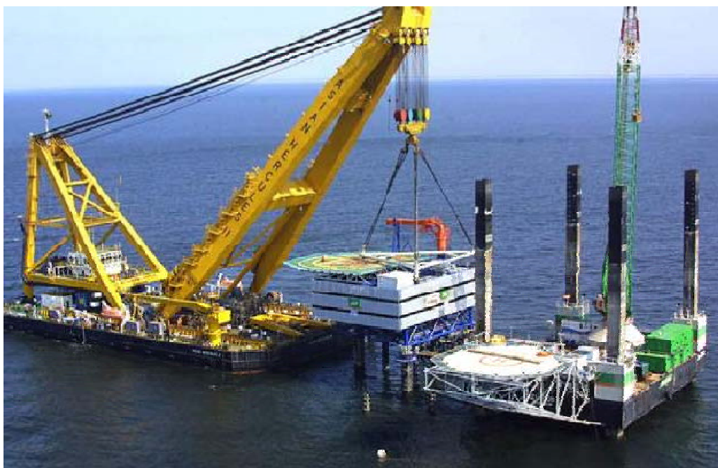
Σχήμα 2: Σε αυτή την εικόνα φαίνεται από πάνω η πλωτή εξέδρα που έχει στηθεί για να γίνουν οι εργασίες της θεμελίωσης. Στην εικόνα φαίνεται και χώρος προσνήωσης ελικοπτέρων για περιπτώσεις ανάγκης γρήγορης μεταφοράς του προσωπικού.
