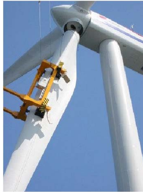
Σχήμα 11: α) Το τρίτο πτερύγιο της ανεμογεννήτριας πάνω στο πλοίο, την ώρα που δένεται στο ανυψωτικό μηχανήμα. β) Τοποθέτηση του τρίτου πτερυγίου στην πλήμνη.
