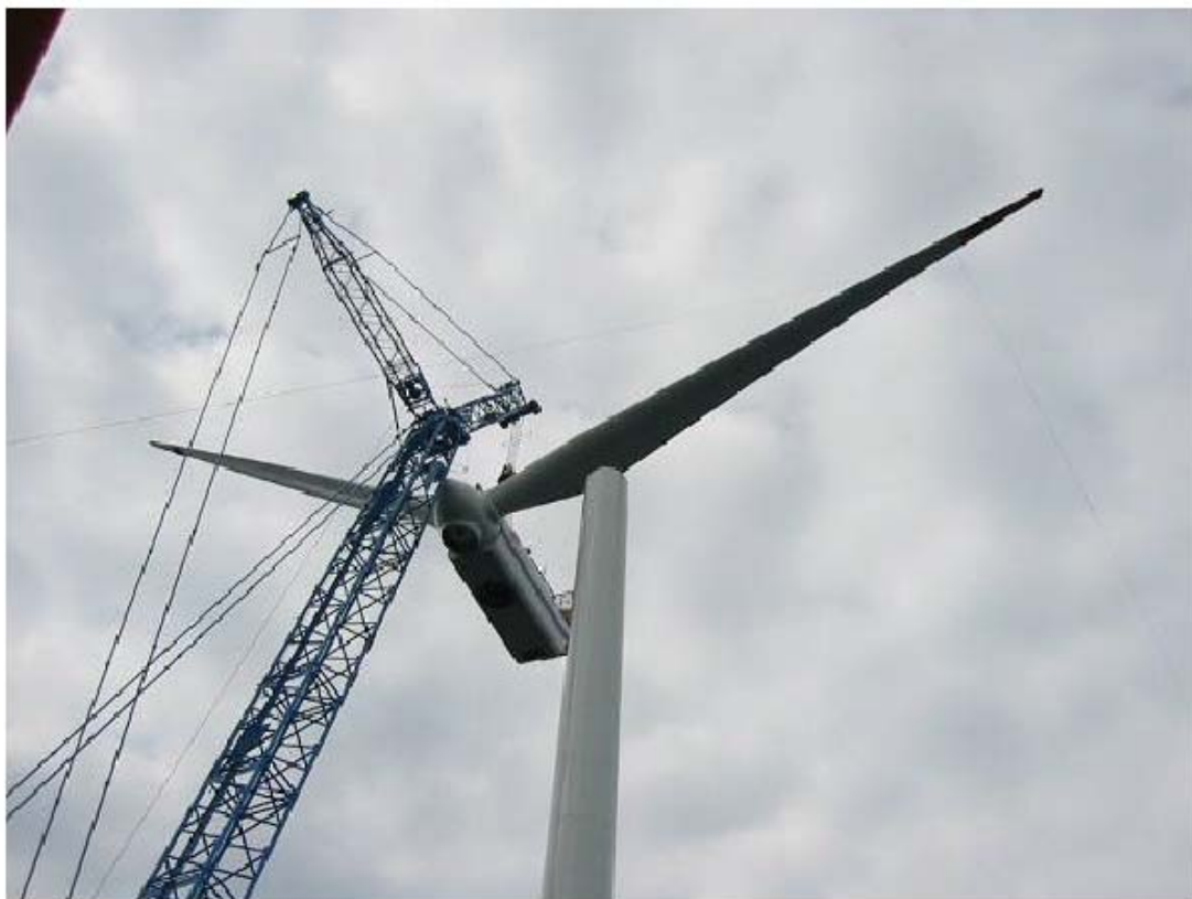
Σχήμα 10: Ανύψωση του κελύφους και τοποθέτησή του στον πύργο. Διακρίνονται τα δύο πτερύγια που έχουν ήδη τοποθετηθεί στη ξηρά ενώ διακρίνεται και η θέση του τρίτου πτερυγίου στην πλήμνη.
