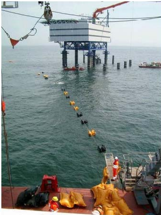
Σχήμα 12: α) Εγκατάσταση των καλωδίων σύνδεσης κατά τη φάση κατασκευής της θεμελίωσης. β) Ολοκλήρωση των εργασιών εγκατάστασης με τοποθέτηση προστατευτικών σημαντήρων γύρω από την ανεμογεννήτρια.
