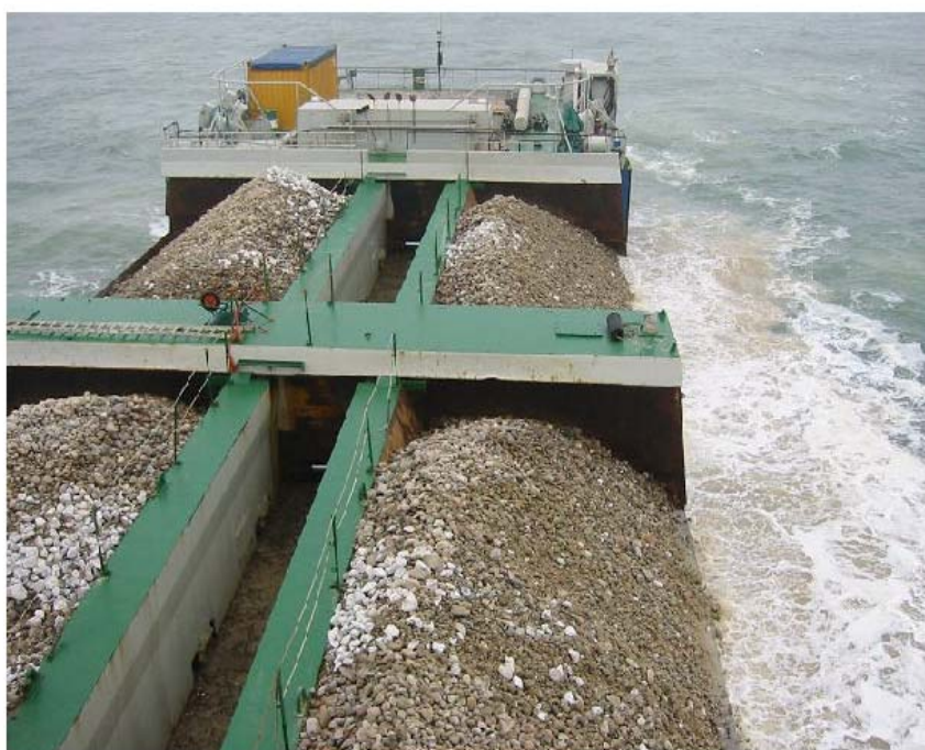
Σχήμα 3: Στην εικόνα φαίνεται μια φορτηγίδα που μεταφέρει χαλίκια και άμμο για τη θεμελίωση του πύργου της ανεμογεννήτριας.
