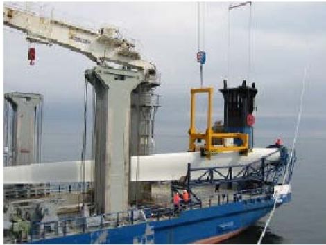
Σχήμα 11: α) Το τρίτο πτερύγιο της ανεμογεννήτριας πάνω στο πλοίο, την ώρα που δένεται στο ανυψωτικό μηχανήμα. β) Τοποθέτηση του τρίτου πτερυγίου στην πλήμνη.
