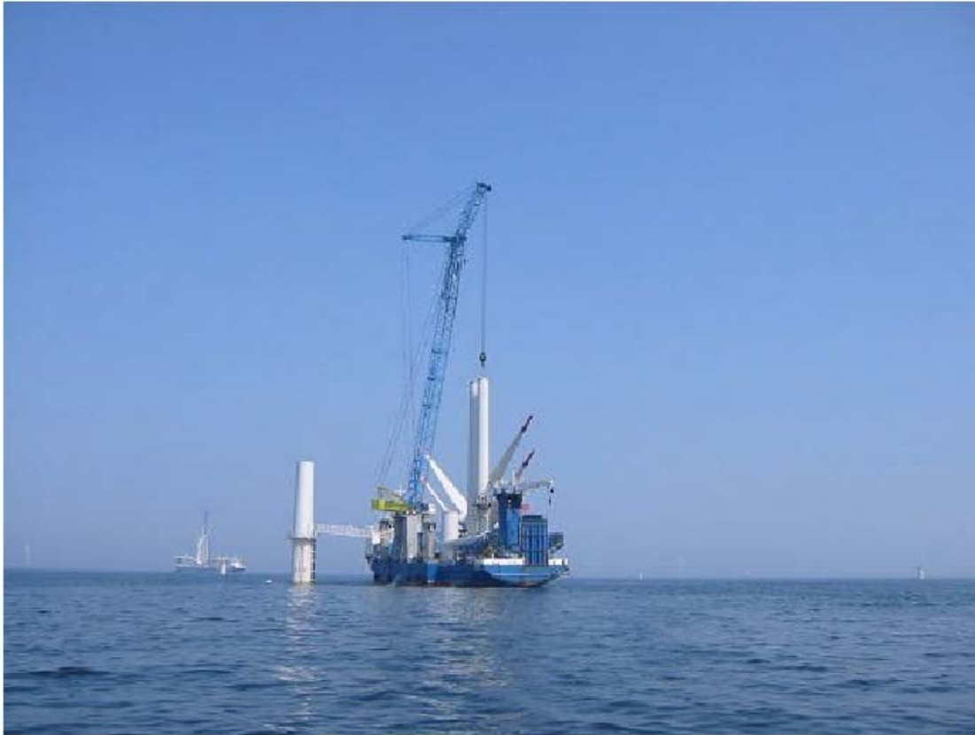
Σχήμα 9: Τα κελύφη λίγο πριν στηθούν στους πύργους.
