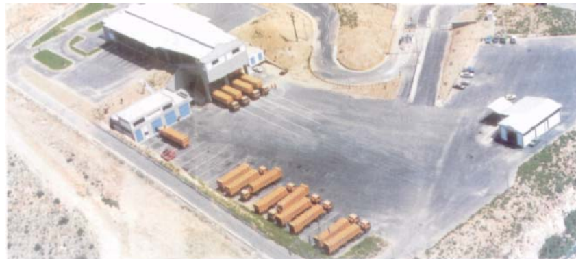
Σχήμα Α.9: Σταθμός μεταφόρτωσης Σχιστού Αττικής (έκταση 30 στρεμμάτων, 4 συμπειστές, 2 τάφροι υποδοχής δυναμικότητας 1500 τόνων ανά δωρο)
