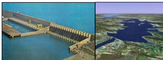
Εικόνα 9: Φράγμα Sobradinho στην κοιλάδα São Francisco (Πηγή: αριστερά: www.ufirj.br/institutos/it/de/acidentes/bigdam.htm , δεξιά: www.gearthacks.com/images/new/080505/798379Clipboard10.jpg )
