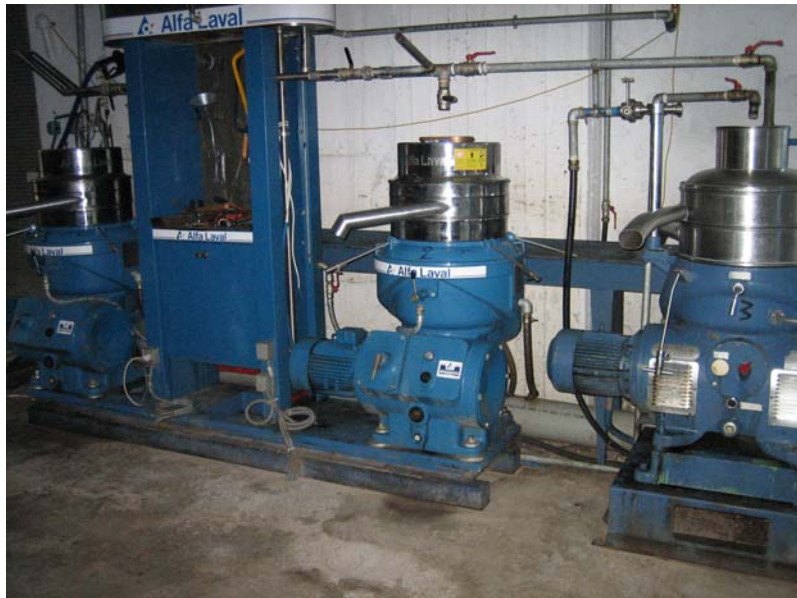
Εικόνα 3.8: Τυπικός ελαιοδιαχωριστήρας
