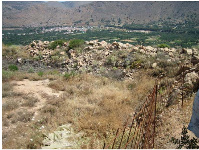
Σχ. 7.12 Κακή κατασκευή δεξαμενής σε υδροπερατά πετρώματα.
