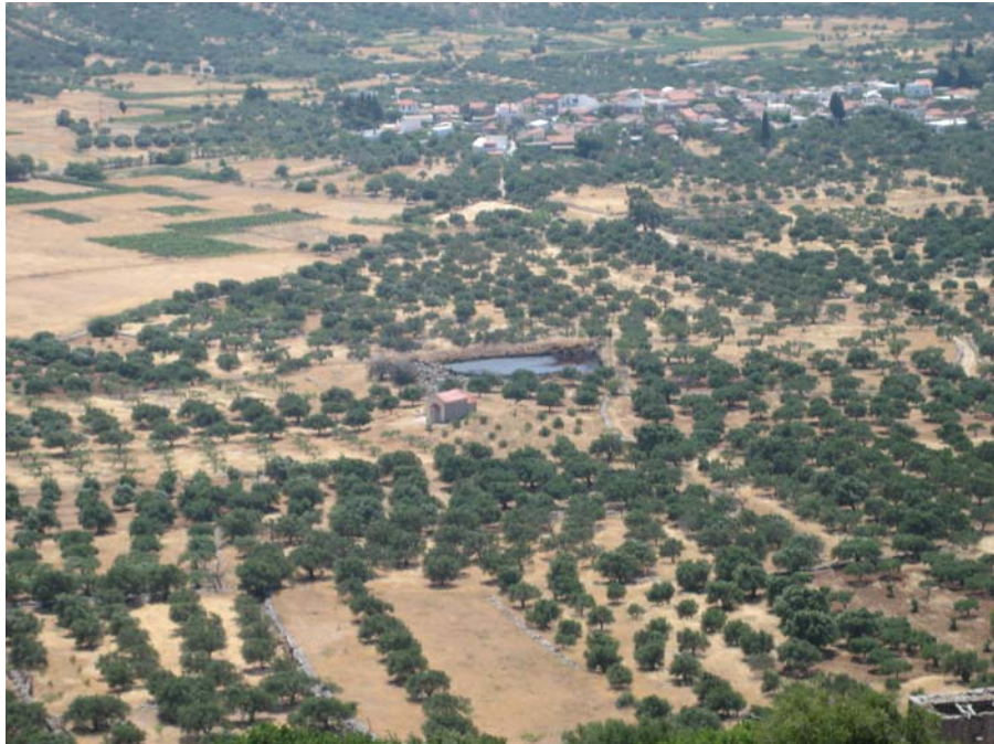
Σχ.7.13 Κακή επιλογή της θέσης της εξατισοδεξαμενής.
