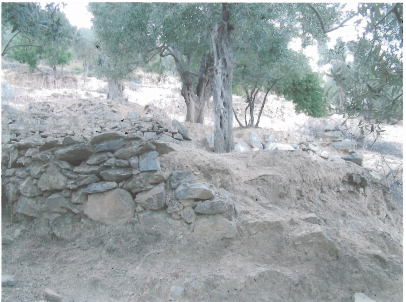
Εικόνα 8. Προβλήματα από μη συντηρημένες αναβαθμίδες σε ελαιώνα της Μυτιλήνης(πρωτότυπη).
