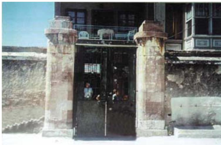
Εικ. 66: Τα «τείχη» της πρόσοψης πριν την κτιριακή αποκατάσταση του 1998
