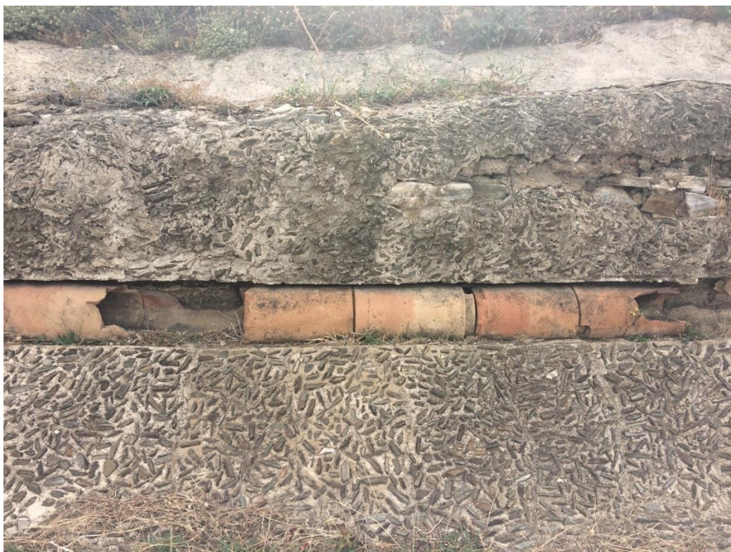
Εικ. 6 τμήμα υδραγωγείου με πήλινους αγωγούς στις Μέλανες.
