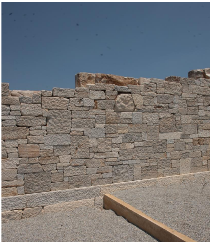
Εικ. 32 τμήμα του βόρειου τοίχου από το εσωτερικό του ναού.
