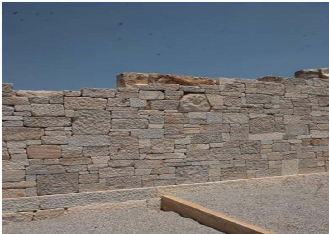
Εικόνα 4.5: Τμήμα του βόρειου τοίχου από το εσωτερικό του ναού
