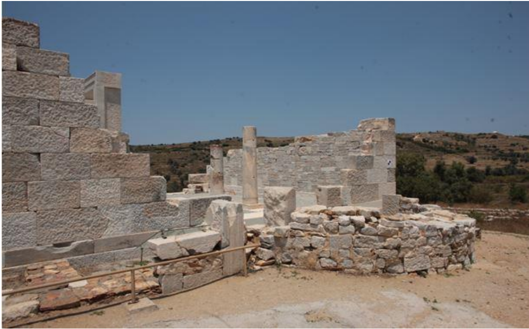
Εικόνα 4.6: Η εξωτερική πλευρά του ανατολικού τοίχου του σηκού
