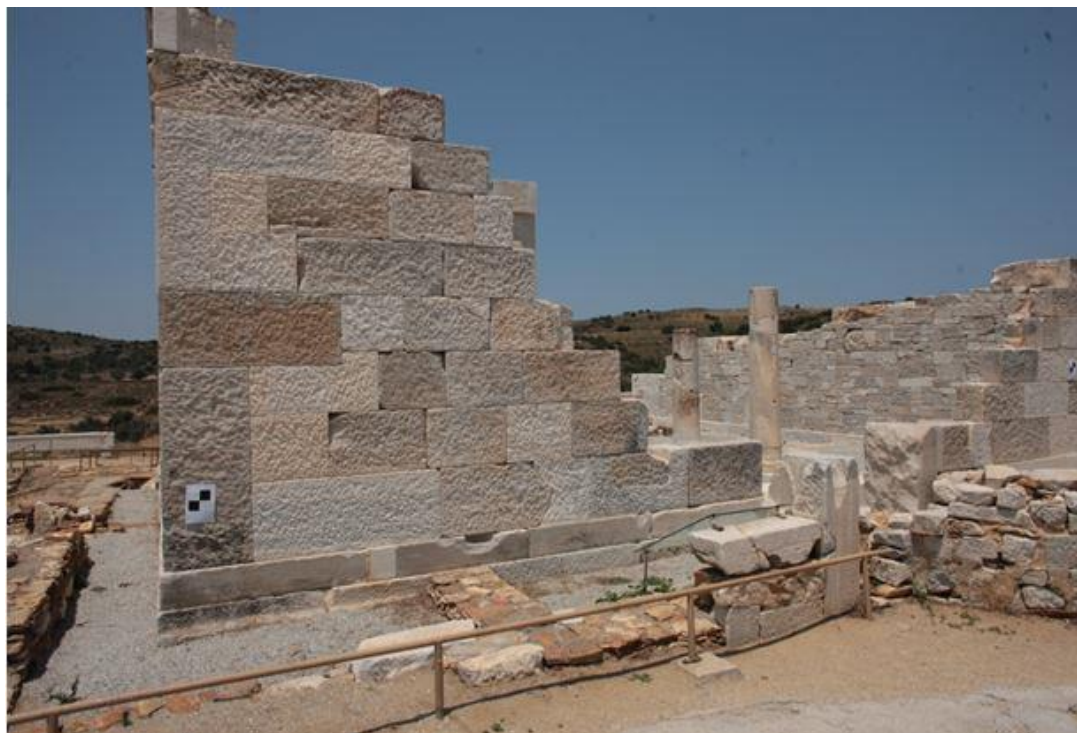
Εικόνα 4.8: Τμήμα του ανατολικού τοίχου του προνάου
