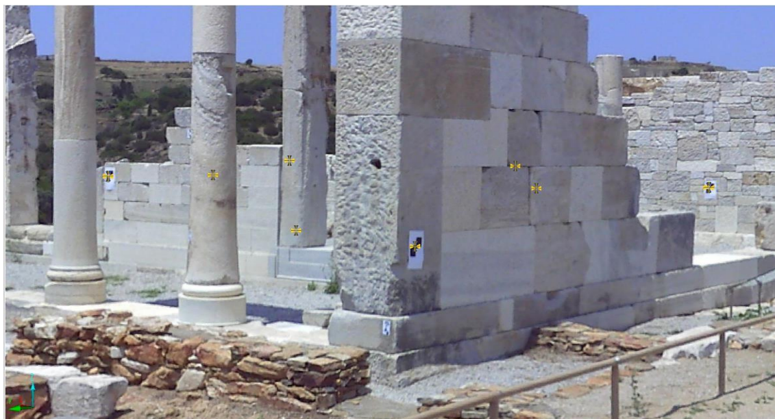
Εικόνα 4.14: Σκόπευση φωτοσταθερών στη φωτογραφία στο λογισμικό Faroscene
