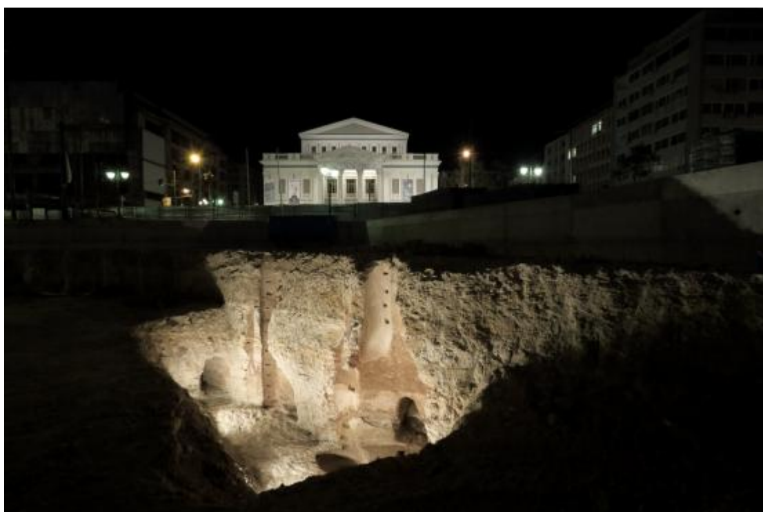
Εικ. Β4. Άποψη της εκσκαφής για την κατασκευή του σταθμού απέναντι από το Δημοτικό Θέατρο. Διακρίνονται σε τομή οι αρχαίες υπόγειες κατασκευές, λαξευμένες στο φυσικό βράχο (φωτ. Σ. Σπυρίδωνος).
