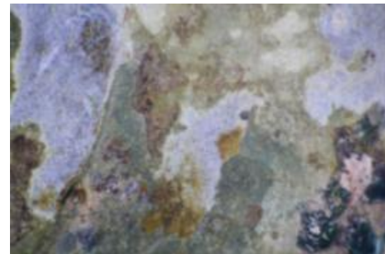
Εικ. Γ15. Υποπράσινο στρώμα διάβρωσης 2
