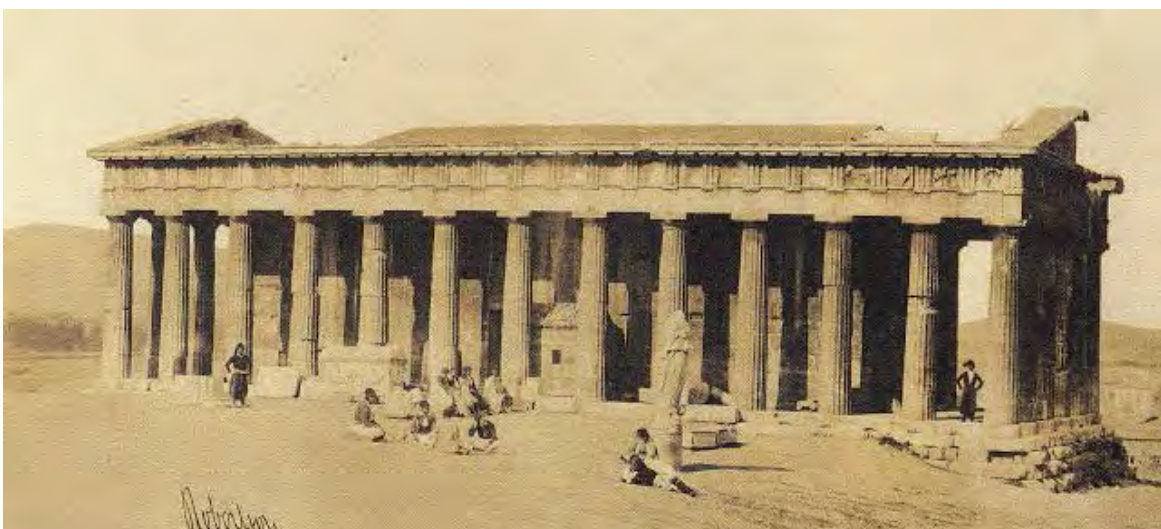
Εικ.59 Φωτογραφία του J.Robertson, ανάμεσα στο 1850 – 1888, στην οποία διακρίνεται προσθήκη στον χώρο του πτερού (Η παλιά Αθήνα).
