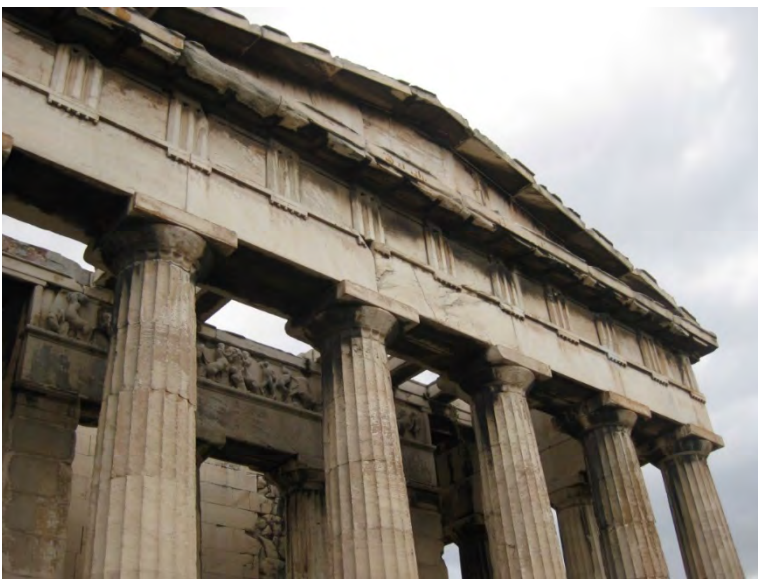
Εικ.67 Άποψη της δυτικής όψης του ναού στην υφιστάμενη κατάσταση. Διακρίνονται οι χαρακτηριστικές επικαθίσεις μαύρης κρούστας, λόγω ατμοσφαιρικής ρύπανσης (προσωπικό αρχείο).
