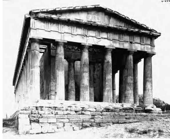
Εικ.49 Η δυτική όψη του ναού. Διακρίνονται οι αναβαθμοί της κρηπίδας και το θεμέλιο (Agora.ascsa.net).
