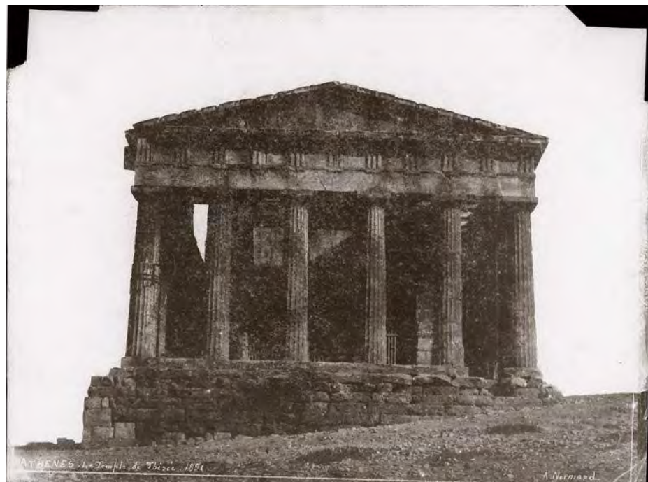
Εικ.6 Φωτογραφία του Alfred N. Normand περίπου το 1850, της δυτικής όψης του ναού του Ηφαίστου. Διακρίνονται η θεμελίωση του ναού, μεταλλικό κιγκλίδωμα που υπήρχε στον οπισθόδομο, καθώς και περίσφιξη στον ακραίο κίονα, λόγω βλάβης σε μεσαίο σφόνδυλο (Η παλιά Αθήνα).
