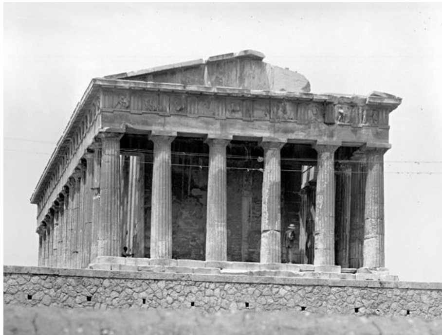
Εικ.63 Η ανατολική όψη του ναού, στην οποία διακρίνεται ο τοίχος από λιθοδομή στη θέση των δύο κιόνων του πρόναου. H. Koch, 1926 (German Archaeological Institute).
