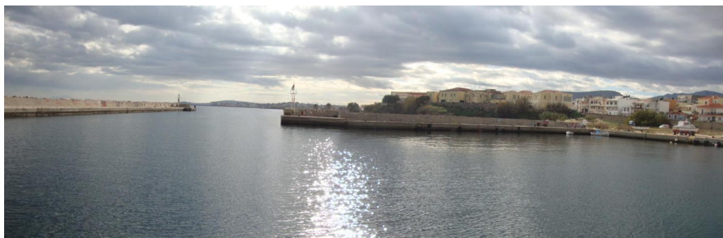
Φωτογραφία 6: Είσοδος Λιμενολεκάνης (Υφιστάμενη)
