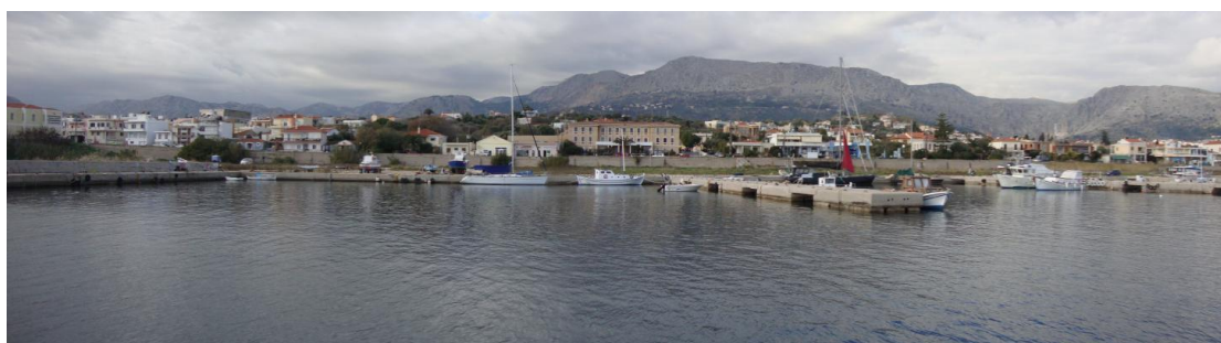
Φωτογραφία 1: Λιμενολεκάνη - Ανατολική Όψη (Υφιστάμενη)
