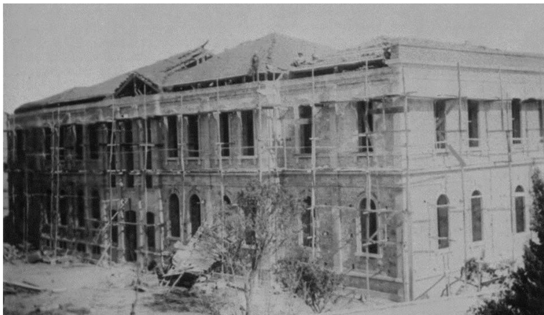
Εικ. 120: Το Οθωμανικό Γυμνάσιο, κατά τη διάρκεια κατασκευής του.
