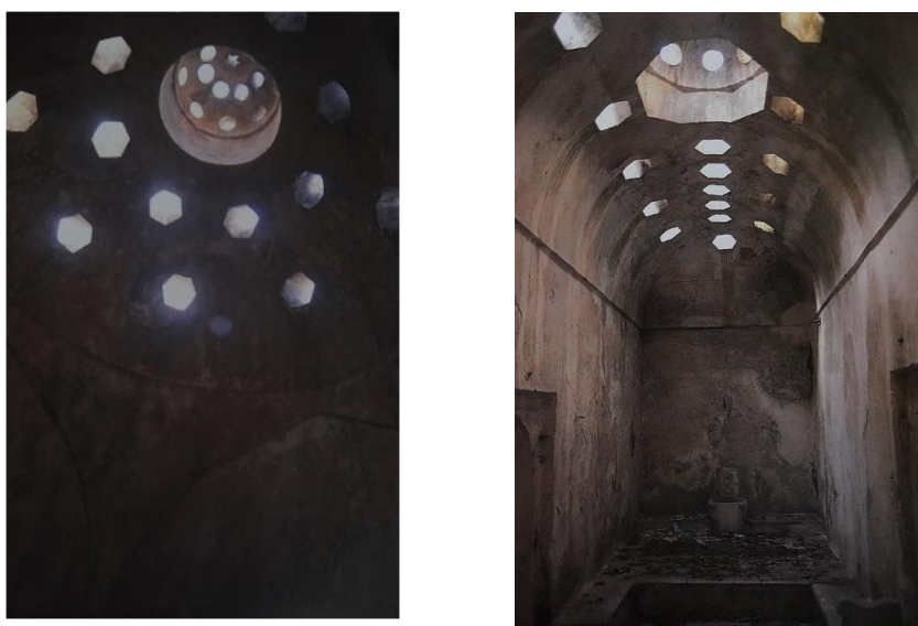
Εικ. 106, 107: Αριστερά: αστεροειδείς φεγγίτες και διάτρητος φανός, Δεξιά: άποψη του χλιαρού χώρου.
