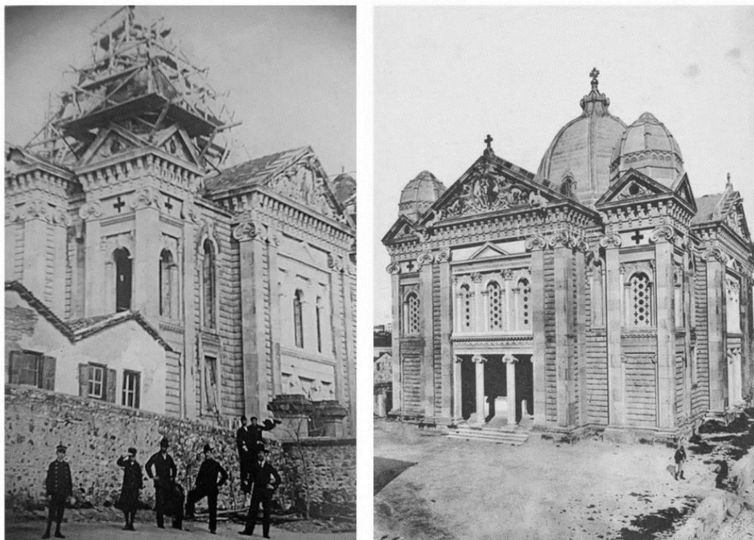
Εικ. 85,86: Άποψη του ναού πριν και μετά την ολοκλήρωση των εργασιών.
