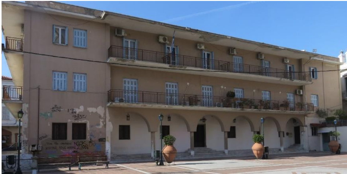
Εικ. 90: Το κτίριο, ιδιοκτησίας Φ.Κ.Μ., στο οποίο στεγάζεται σήμερα το εκκλησιαστικό Βυζαντινό Μουσείο.
