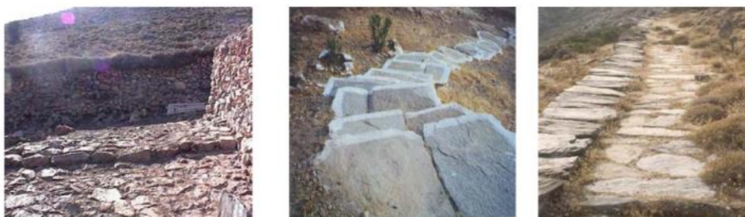
Εικόνα 1.44 - Φωτογραφίες τρίτης κατηγορίας: Πλακόστρωτη αυλή μαντριού στην Πάτμο, πλακόστρωτο μονοπάτι στην Άνδρο (Φωτογραφία κ. Τίτου Γιοχάλα) και πλακόστρωτο μονοπάτι στην Λέσβο.
