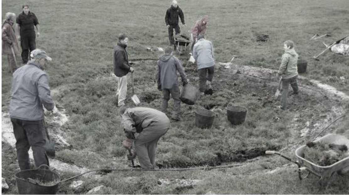
Εικόνα 1.9 - Κατασκευάζοντας τη λίμνη δρόσου
