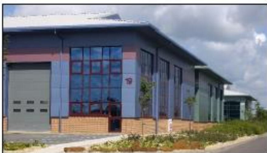
Σχήμα 2.8. Μεγάλα παράθυρα και χρήση σύνθετων πάνελ με τούβλο "dado"
