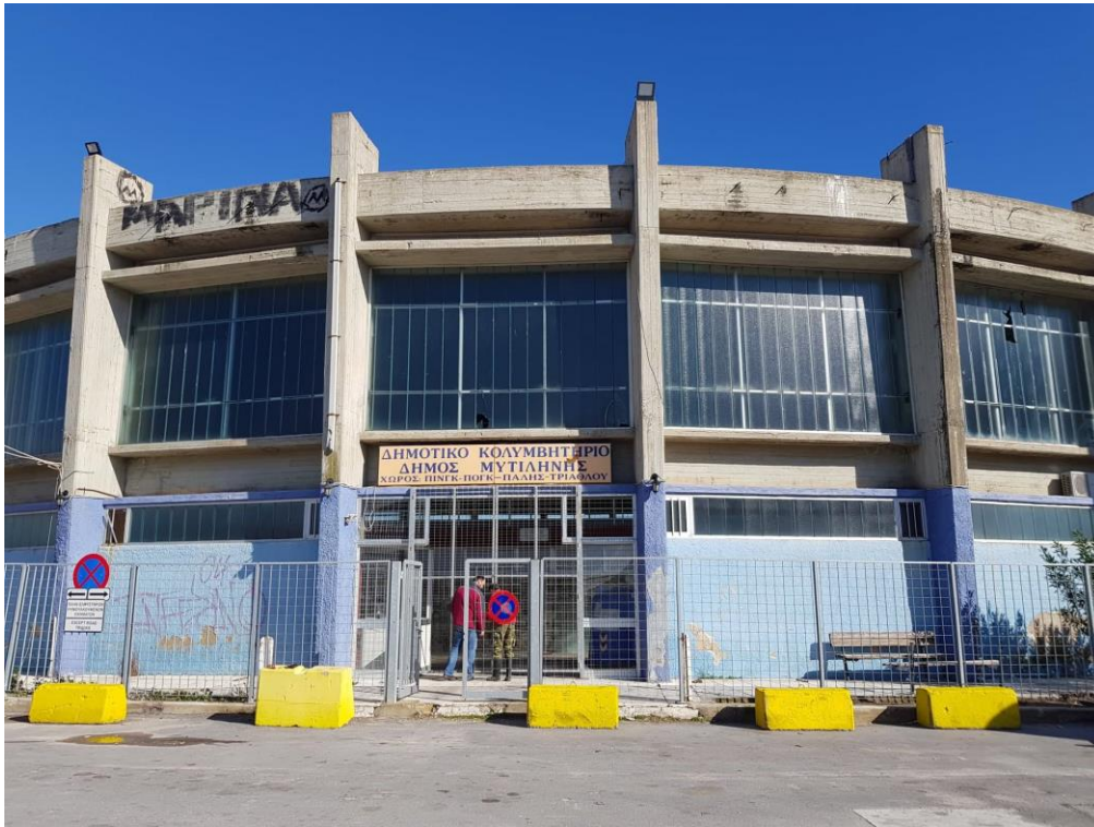
Εικόνα 1.6 Δυτική Είσοδος - Όψη Κολυμβητηρίου.
