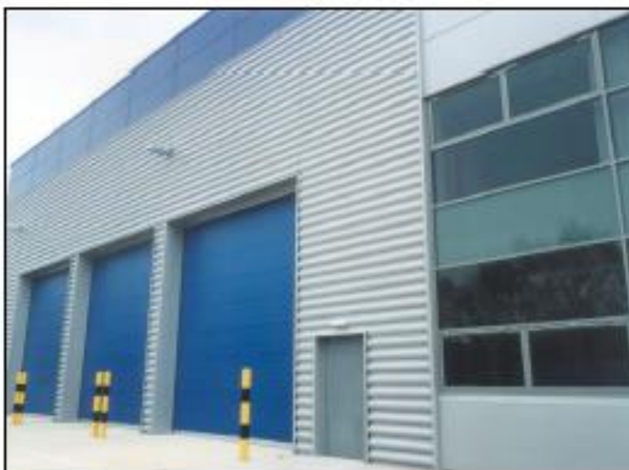
Σχήμα 2.7. Οριζόντια επίστρωση στην ανατολική όψη του κτηρίου
