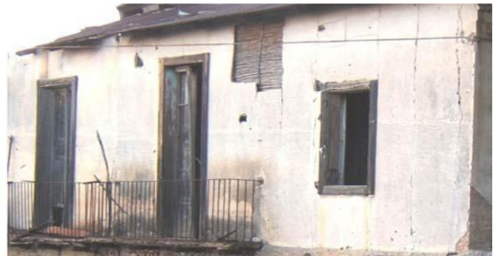
Εικόνα 12 Αγροτικά κτίρια στη νότια Ιταλία με εξωτερικούς τοίχους με επένδυση από Arundo donax
