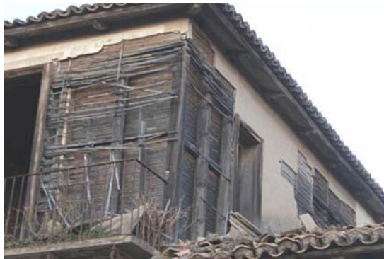
Εικόνα 12 Αγροτικά κτίρια στη νότια Ιταλία με εξωτερικούς τοίχους με επένδυση από Arundo donax
