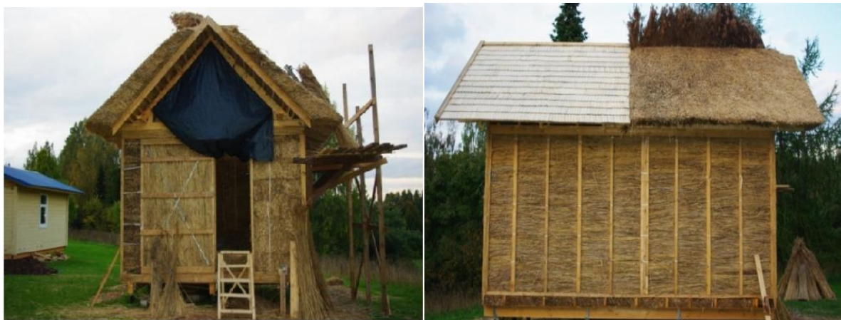
Εικόνα 1 (α) Πρόσοψη σπιτιού με πάνελ δόμησης από Μπαμπού , (β) πλάγια όψη κατασκευασμένη με πάνελ δόμησης από Μπαμπού.
