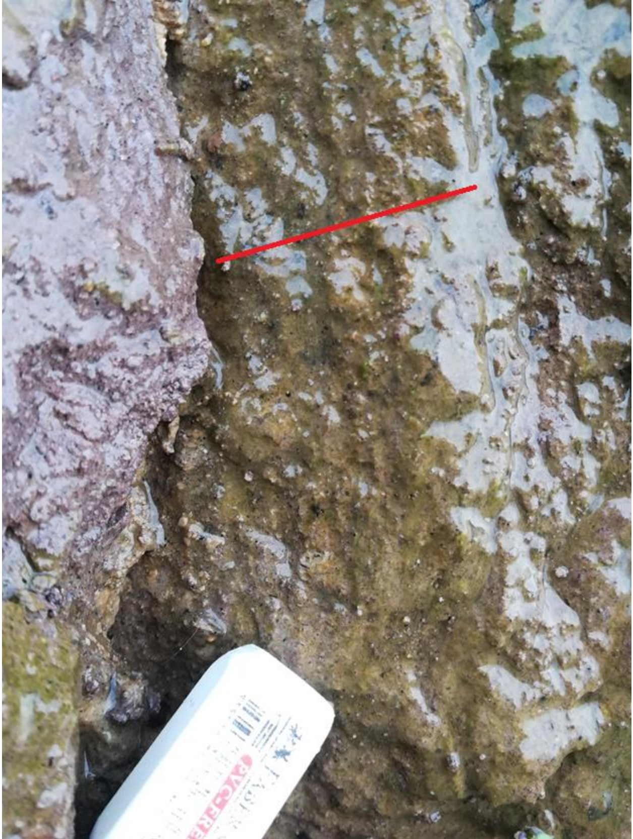
Εικόνα 101: Γράμμιση τεκτονικής ολίσθησης.
