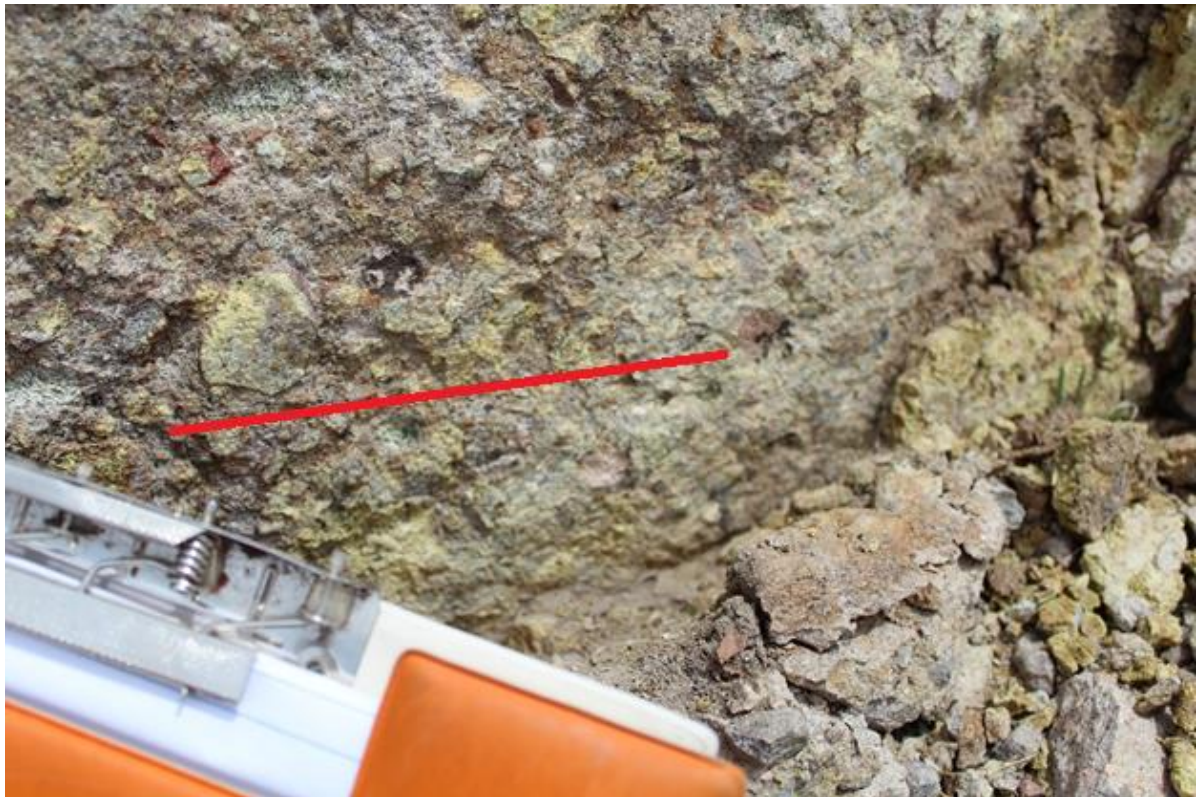
Εικόνα 288: Γράμμωση τεκτονικής ολίσθησης.
