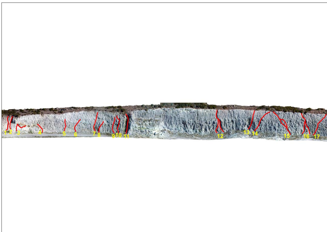
Εικόνα 6.9: Πρηνές με ρήγματα στη θέση 2.
