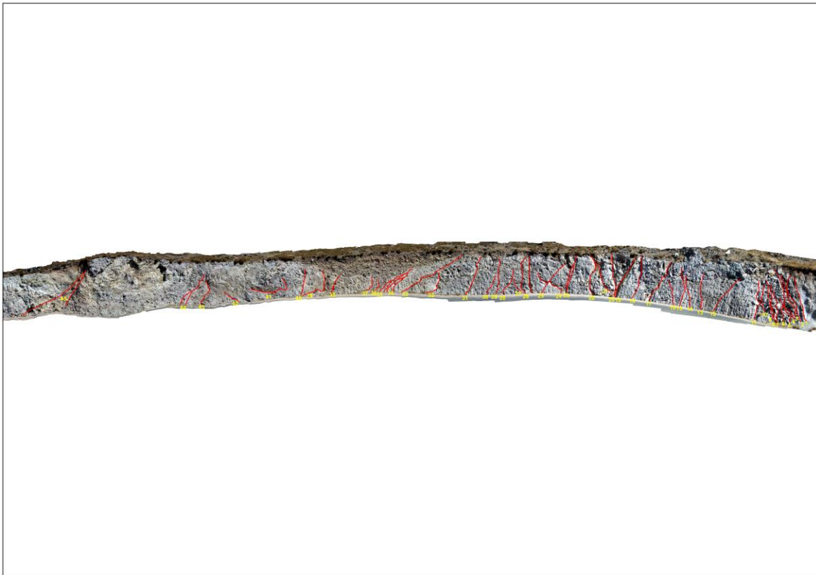
Εικόνα 6.15: Πρανές με ρήγματα στη θέση 4.
