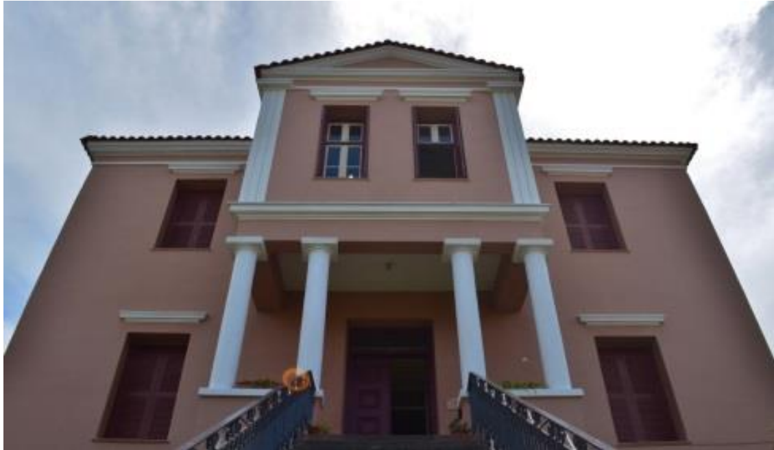
Φωτογραφία 3: Πρόσοψη κτηρίου Δημοτικής Πινακοθήκης Μυτιλήνης
