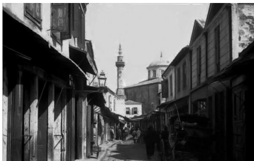
Η οδός Ερμού-Γενί Τζαμί
