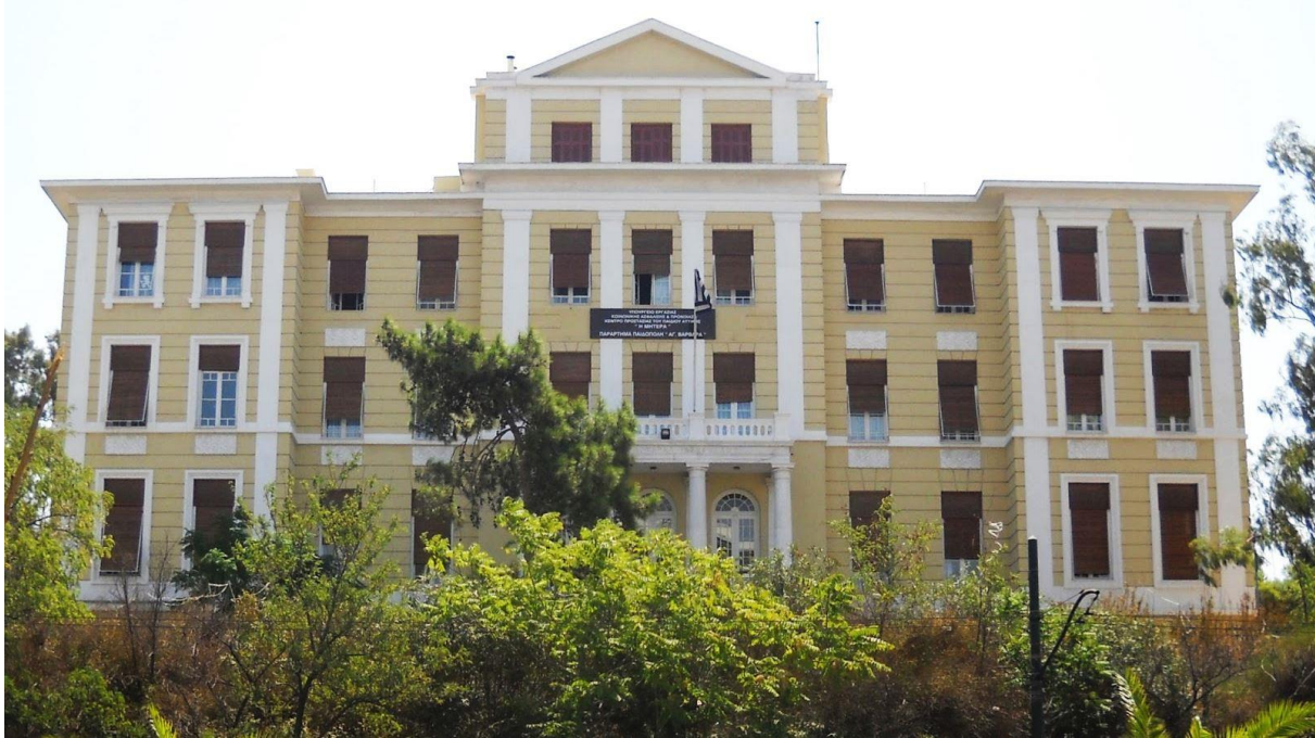
Φωτογραφία 1 -Ιωσηφόγλειο ορφανοτροφείο. Διατηρητέο κτίσμα
