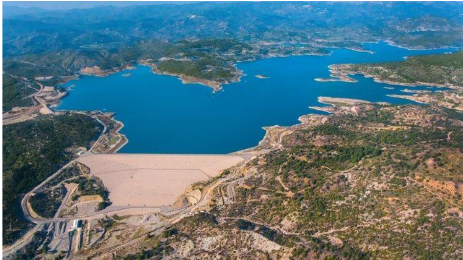
Εικ.28. ΦΡΑΓΜΑ ΓΑΔΟΥΡΑ. ΤΟ ΜΕΓΑΛΥΤΕΡΟ ΤΕΧΝΙΚΟ ΕΡΓΟ ΣΤΟ ΑΙΓΑΙΟ.
