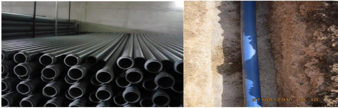
Εικόνα 23 (α) Αγωγοί ύδρευσης, (β) Εγκατάσταση αγωγού ύδρευσης.
