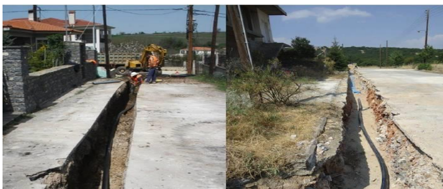
Εικόνα 26. Εργασίες αντικατάστασης αγωγών ύδρευσης.
