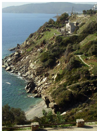
Δεύτερη κατοικία γνωστού δημοσιογράφου που λόγω τοποθέτησης σε σαθρό έδαφος κατολίσθησε και κατέστη επικίνδυνη προς κατοίκηση Αριστερά κοντινό πλάνο, δεξιά μακρινό
