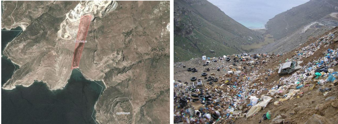
Χώρος ανεξέλεγκτης διάθεσης απορριμμάτων Άνδρου (ΧΑΔΑ) Αριστερά αεροφωτογραφία – Δεξιά άποψη πριν την κατολίωση της χωματερής αρχές του 2011 (αριστερή φωτογραφία πηγή :
