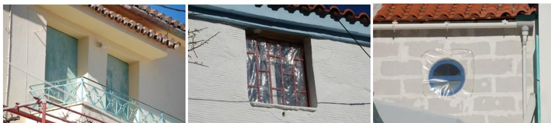
Περιοχή Αποικίων : κλειστές το χειμώνα κατοικίες με πρόσθετα εξώφυλλα
