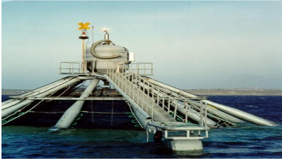
Εικόνα 6: Υπεράκτιος ιχθυοκλωβός, με σύστημα αυτόματου ταΐσματος των ψαριών.
