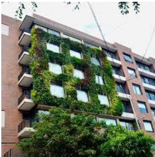
Εικόνα 14 – Κάθετη βλάστηση κτηρίου
