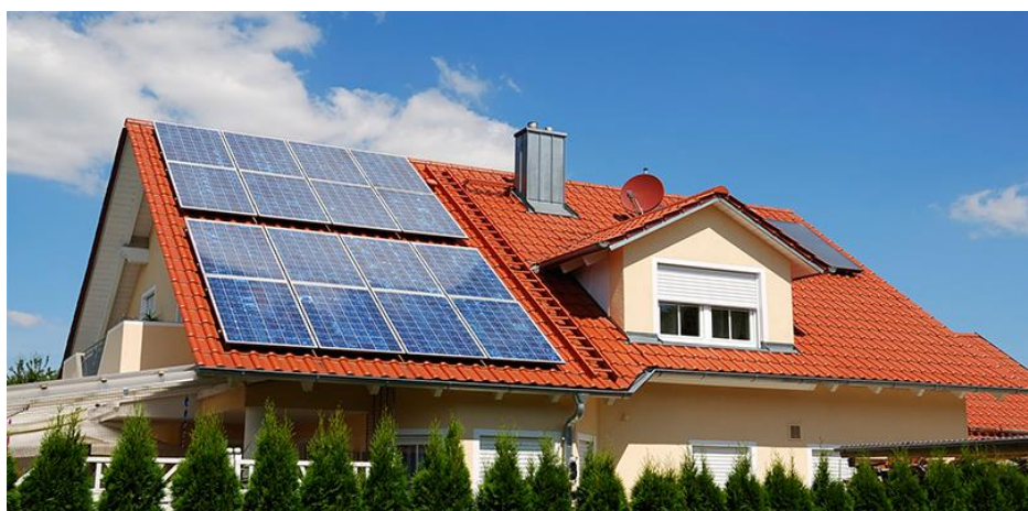
Εικόνα 26 - Φωτοβολταϊκό πάνελ στο κέλυφος κτηρίου
