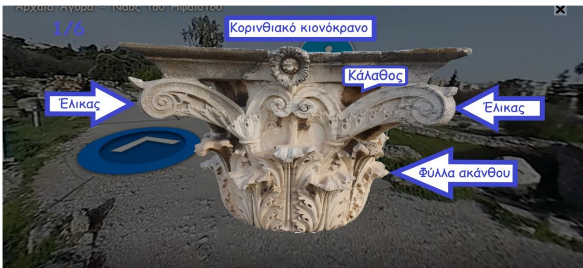
Εικόνα 5.33. Icon button περιγράμματος και το περιεχόμενο για τα δομικά μέρη ενός κιονόκρανου κορινθιακού ρυθμού
