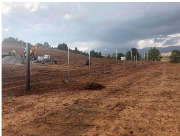
Εικόνα 16. Τοποθέτηση πασσάλων περίφραξης.
