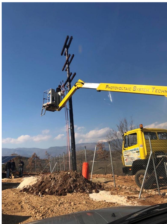
Εικόνα 27. Τοποθέτηση σκάρας καλωδίων.
