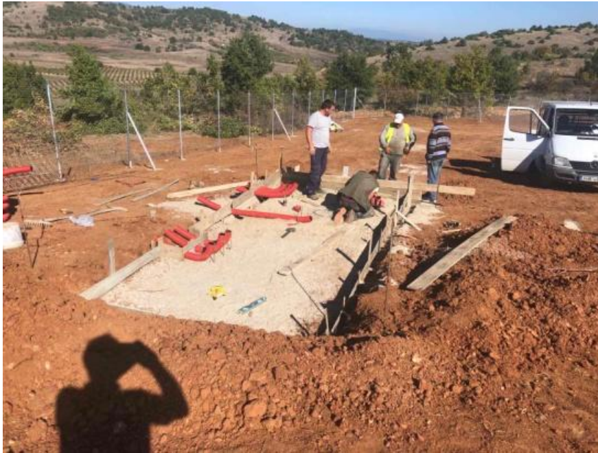
Εικόνα 20. Κατασκευή βάσης υποσταθμού.
