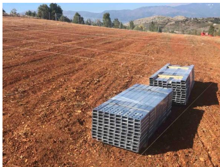
Εικόνα 17. Προετοιμασία για τοποθέτηση πασσάλων βάσεων- ευθυγραμμίσεις.
