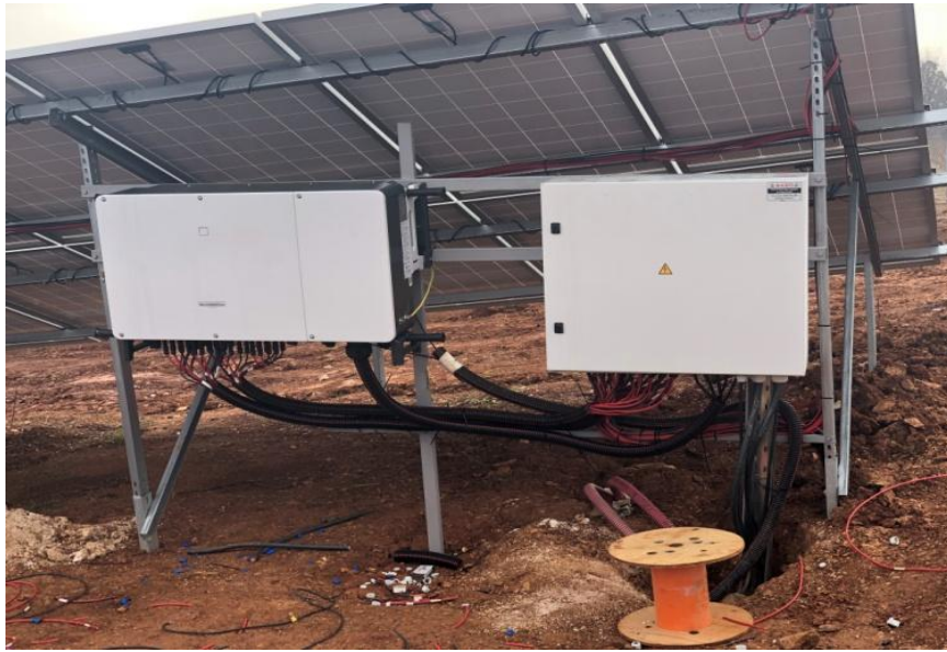
Εικόνα 24. Τοποθέτηση αντιστροφέων και υποπινάκων.
