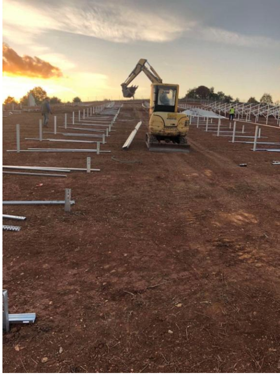
Εικόνα 18. Μεταφορά και μοίρασμα πασαλwv.
