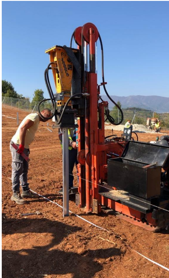
Εικόνα 19. Πασσαλwμwτηξη.
