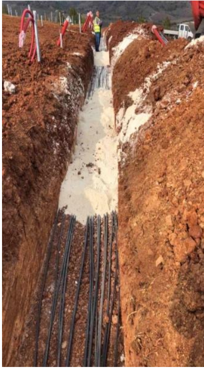
Εικόνα 26. Τοποθέτηση καλωδίων.
