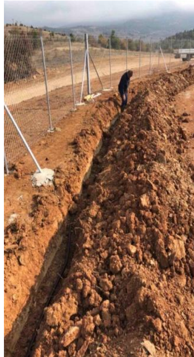
Εικόνα 25. Τοποθέτηση καλωδίων φωτισμού και καμερών.
