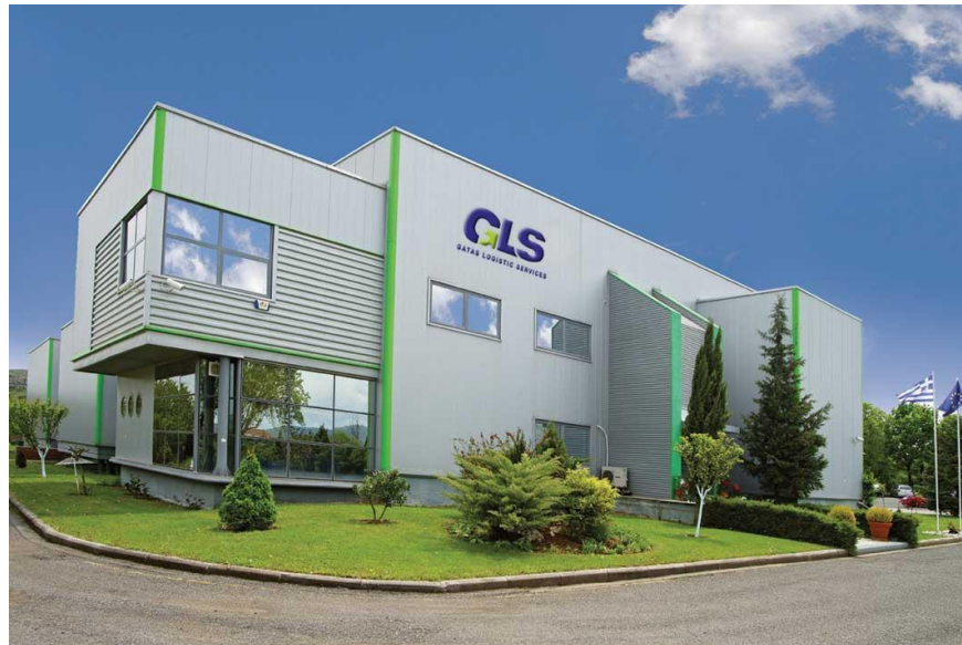
Σχήμα 4.1: Εξωτερική όψη της κτηριακής υποδομής της εταιρίας GLS
