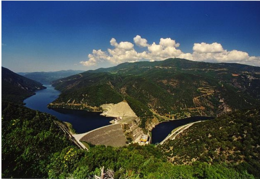
Εικόνα 3-2: Υδροηλεκτρικό έργο Σφηκιάς (πηγή: agrocaptial.gr, 2013).
