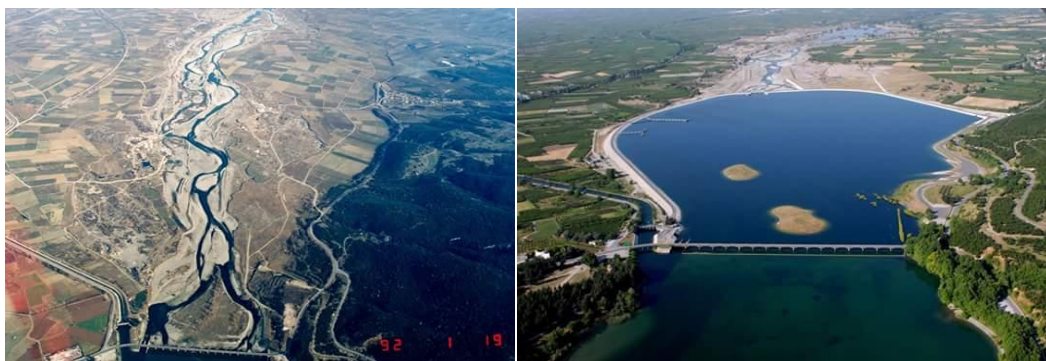
Εικόνα 3-3: Αναρρυθμιστικό έργο Αγίας Βαρβάρας, πριν και μετά (πηγή: ΥΗΣ Σφηκιάς).
