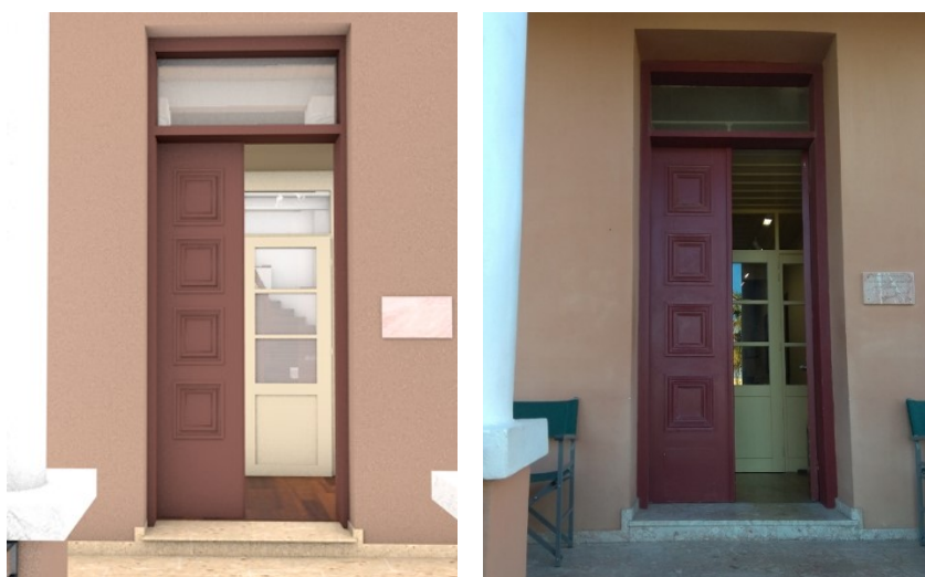
Εικόνα 16. α) Κεντρική πόρτα στο ΕΠ. γ) Κεντρική πόρτα στο πραγματικό χώρο.
