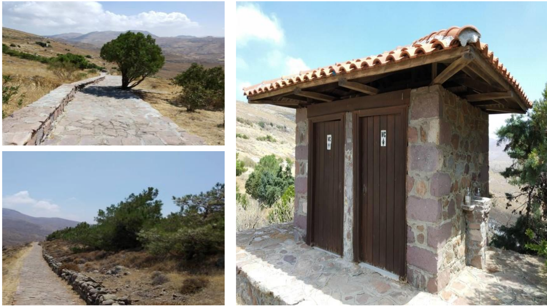
Εικόνα 33: Σκαλοπάτια με τοιχίο συγκράτησης πρανών - Λιθόστρωτο μονοπάτι με ξηρολιθοδομή - Χώρος καθαριότητας (Έτος 2020)
