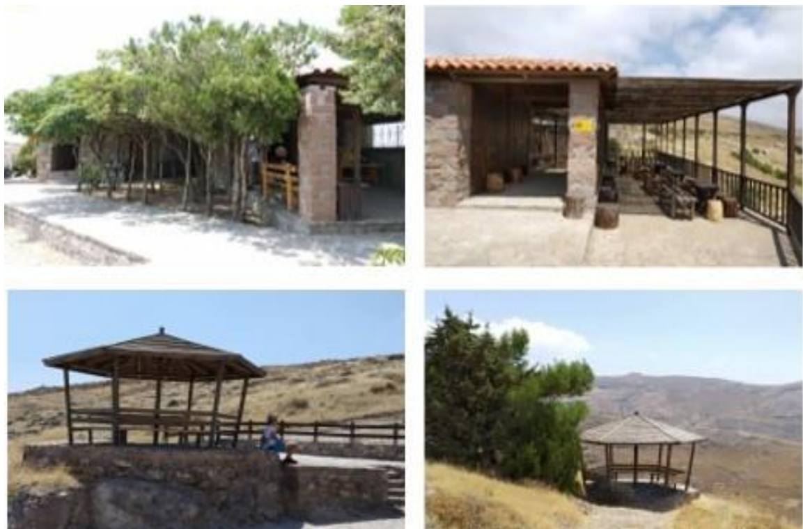
Εικόνα 32: Χώροι υποδοχής - Αναψυκτήριο - Θέσεις θέας (Έτος 2020 )
