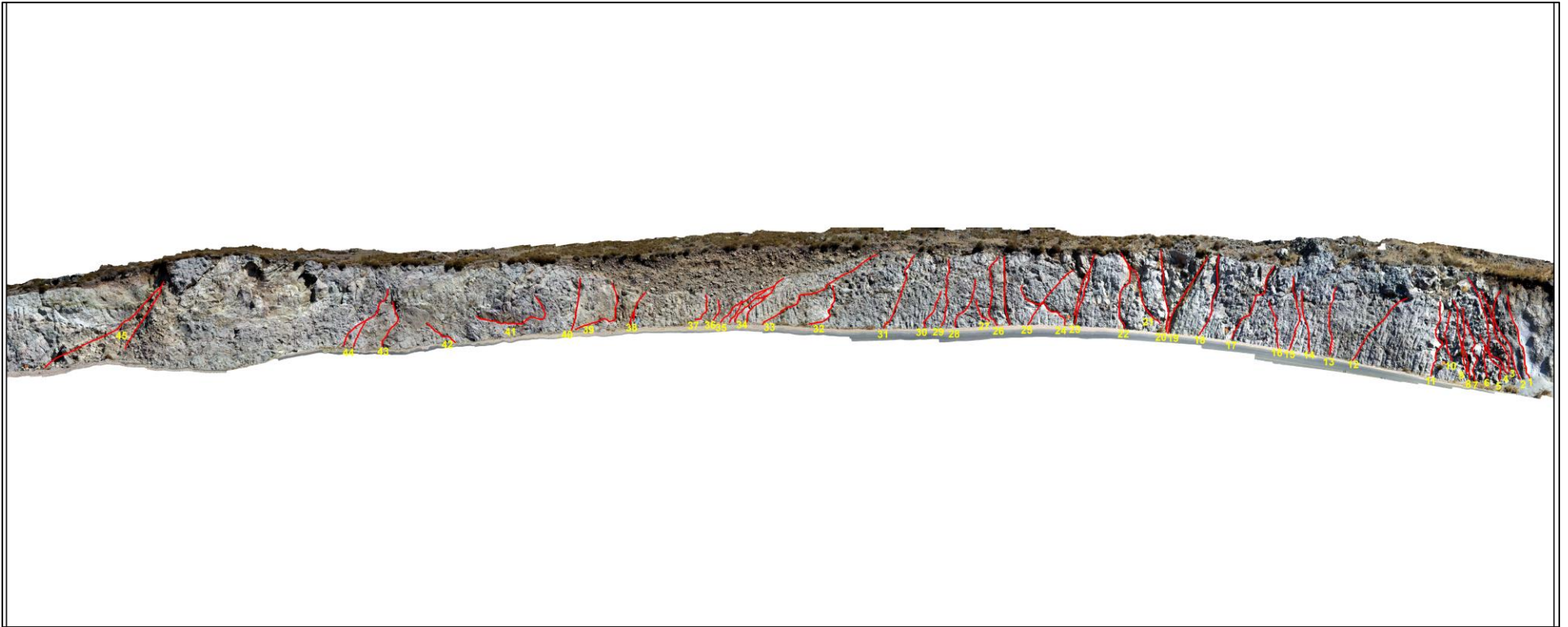
Εικόνα 70: Ορθοφωτομωσαϊκό του πρανούς στη θέση 4.
