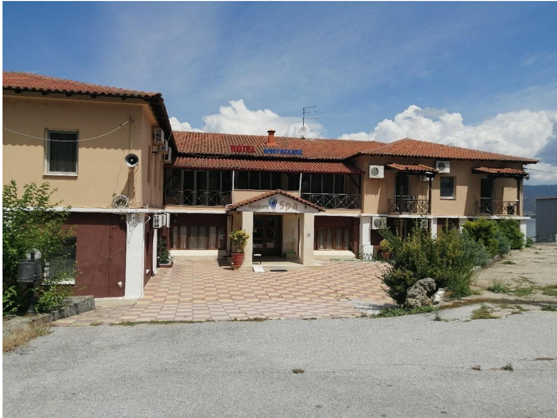
Εικόνα 4.13: Εξωτερικός χώρος των εγκαταλελειμμένων εγκαταστάσεων των Λουτρών Νέας Απολλωνίας (από προσωπική συλλογή).
