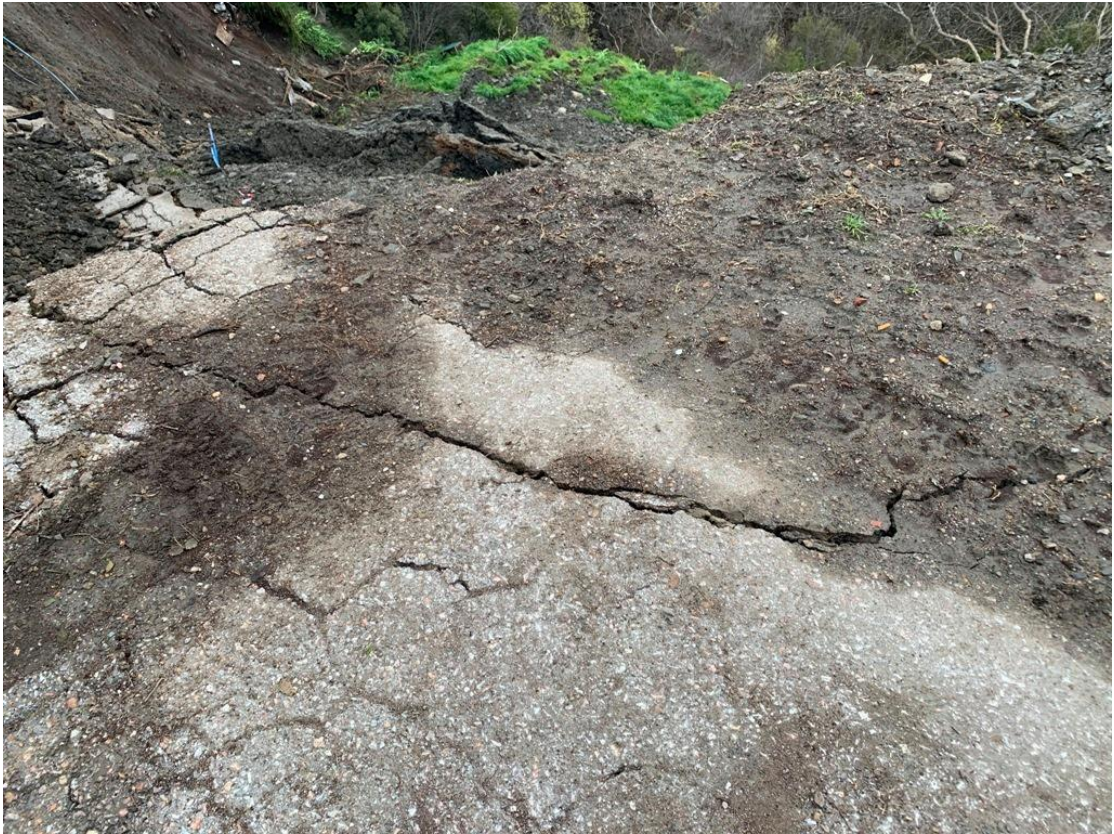
Εικόνες 7.5 και 7.6: Καθίζηση του οδοστρώματος (προσωπική συλλογή)
