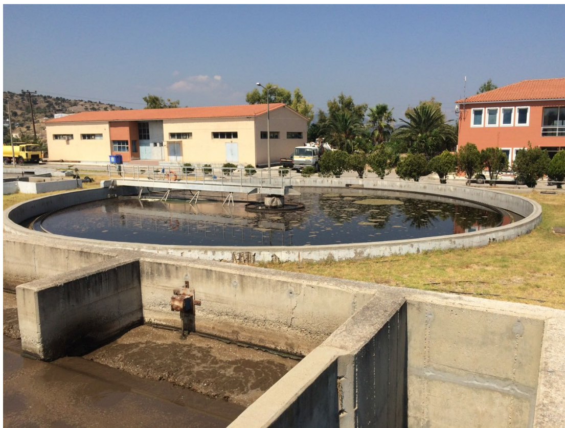
Εικόνα 7 - Δεξαμενή καθίζησης (φωτογραφία συγγραφέα)
