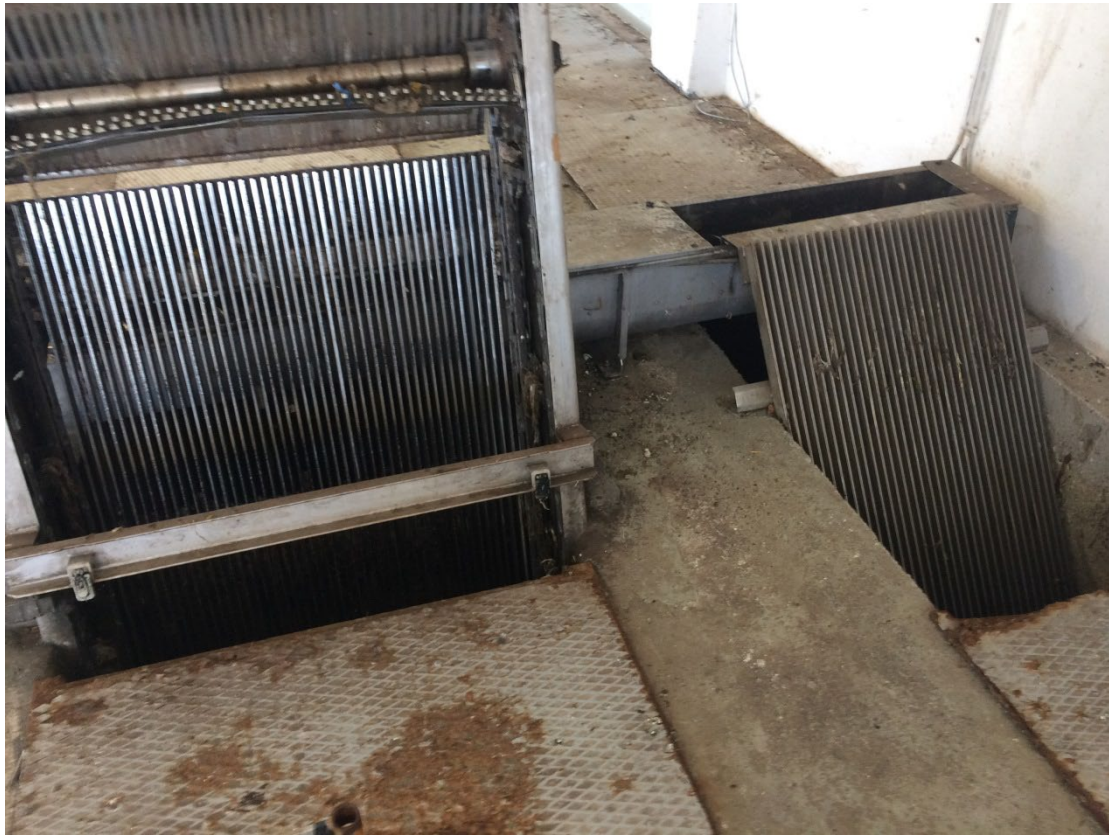
Εικόνα 3 - Μονάδα εσχάρωσης (φωτογραφία συγγραφέα)
