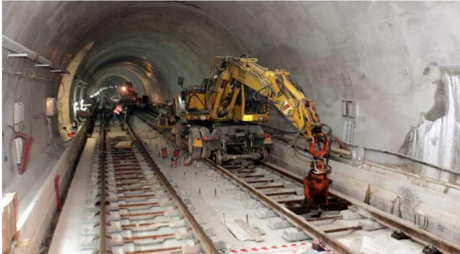
Εικ. 20: Η κατασκευή του Μετρό της Ντόχας. Πηγή: www.economy365.gr 133
