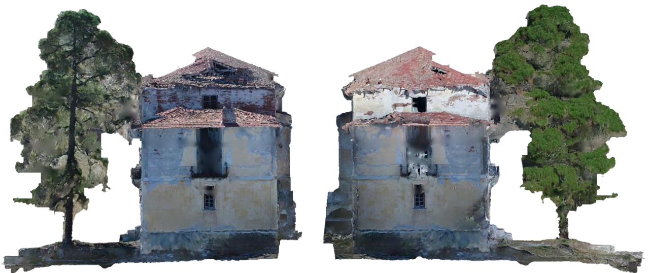
Εικόνα 21: (α,β) Ορθομωσαϊκά βορειοδυτικής και νοτιοανατολικής όψης ιστορικού μνημείου
