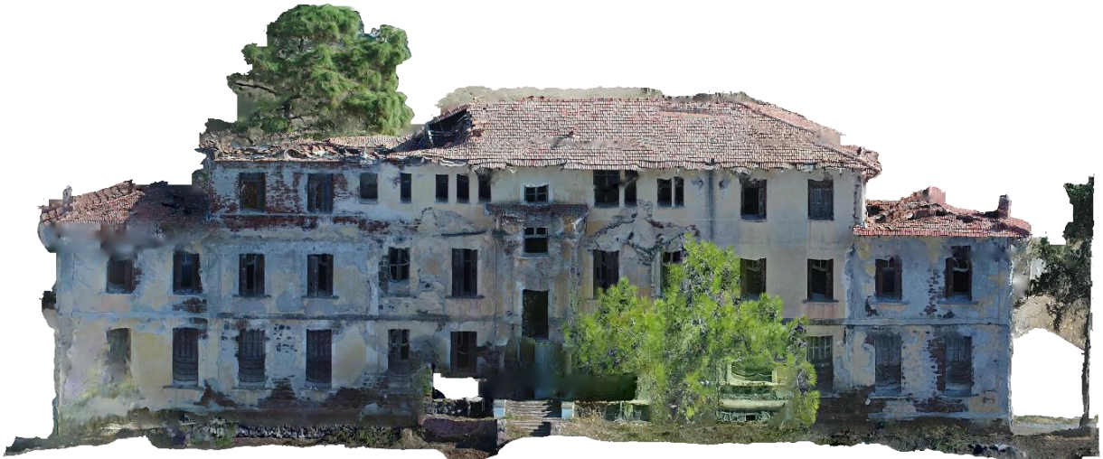
Εικόνα 20: Ορθομωσαϊκό νοτιοδυτικής όψης ιστορικού μνημείου
