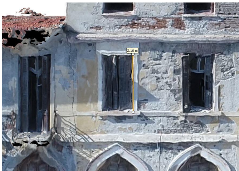
Εικόνα 30: Μέτρηση ύψους παραθύρου στον όροφο
