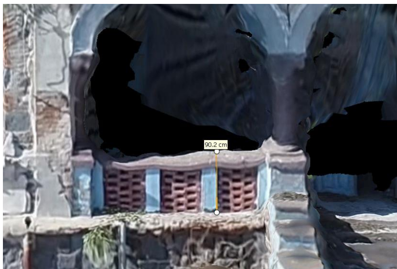
Εικόνα 27: Μέτρηση ύψους στηθαίου εισόδου
