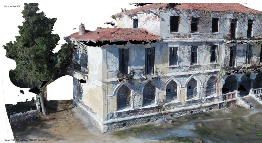
Εικόνα 36: Αλλοιώσεις στα παράθυρα του πρώτου ορόφου και η βλάστηση σε άμεση επαφή με το κτίριο
