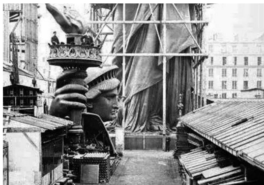
Εικόνα 10: Το εσωτερικό του αγάλματος κρύβει έναν σκελετό σαν αυτόν του πύργου του Αιφελ
