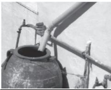
Εικόνα 10: Ομβριοδεξαμενή σε κατοικία. Πηγή: Μητροπούλου κ.α,2013
