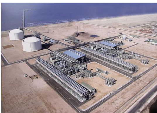
Εικόνα 7: Εγκαταστάσεις υγροποίησης φυσικού αερίου στο Ιντκού
