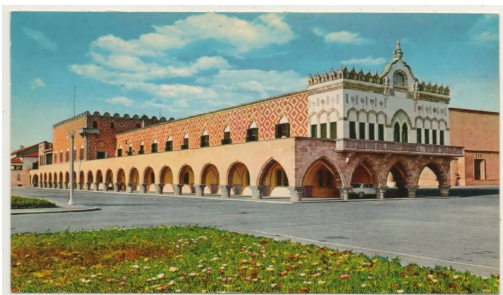
Εικόνα 26: Ρόδος το Διοικητήριο. Η Ιταλική περίοδος της Δωδεκανήσου Πηγή, Ροδιακή
