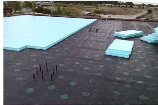
Εικ. 16 Θερμομόνωση ταράτσας (Macon 2021)
