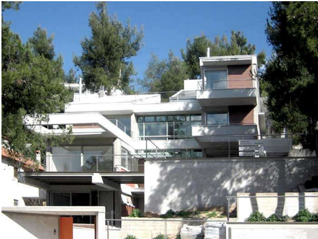
Εικ. 62 Εξωτερική άποψη
